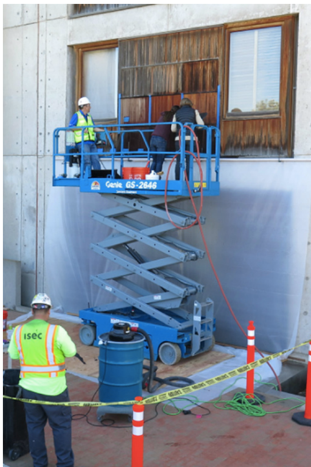
Fig. 2. Salk Institute for Biological Studies. Una fase della sperimentazione dedicata ai saggi di pulitura su mock-up (J. Paul Getty Trust 2016).
