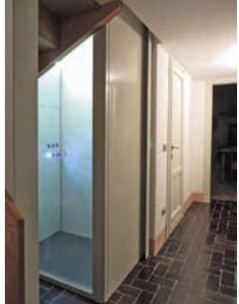
Fig.02-03 Piattaforma elevatrice e contesto al piano terra, con barco della piattaforma elevatrice al primo piano. Il vano corsa trasparente consente sia di vedere la scala dagli ambienti e di vedere la casa dall'interno della cabina. La trasparenza è particolarmente importante quando la cabina, come in questo caso, è piuttosto piccola così da non risultare opprimente per il passeggero.
