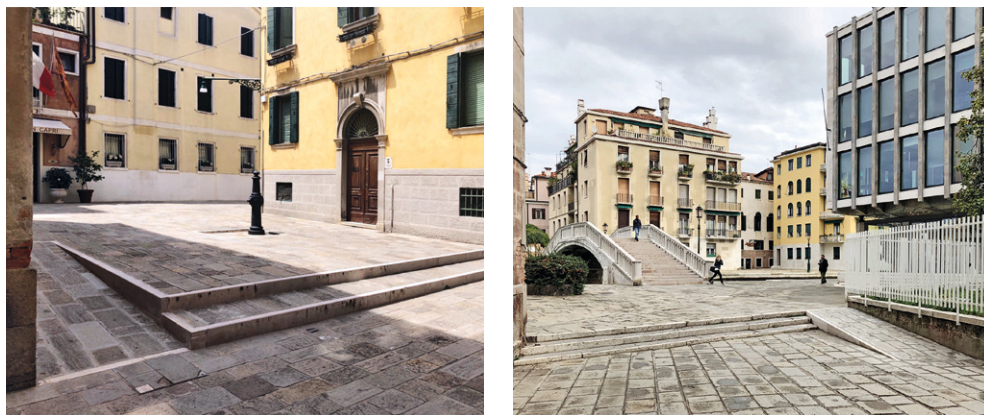
Fig.05 Esempi di nuove rampe realizzate per il superamento di piccoli dislivelli urbani. A seconda delle condizioni dell'area interessata, esse possono essere ottenute per sottrazione (a) o addizione (b), in entrambi i casi dando continuità alla pavimentazione esistente in quanto rivestite in trachite con bordi in pietra d'Istria. R.Revellini
