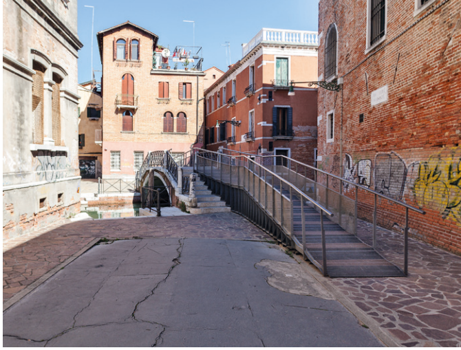
Fig.02 Ponte Ognissanti: vista della rampa a gradino agevolato sovrapposta al ponte realizzata nel 2015. La struttura della rampa, in lamiera pressopiegata in acciaio, segue il profilo della gradonata esistente su cui si appoggia rispettando in tal modo il criterio di reversibilità, oltre a caratterizzarsi per il suo aspetto formale. R.Revellini
