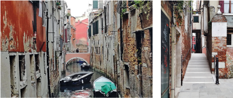
Fig.03 Ponte Raspi: prospetto del ponte dal rio delle Beccherie e vista del camminamento interno. Il ponte, ricostruito nel 1824 dopo averne abbattuto uno preesistente, è stato interessato da un intervento per l'accessibilità nel 2017 che ha modificato interamente la conformazione interna, eliminando le due rampe gradonate, sostituite da rampe a gradino agevolato. R.Revellini
