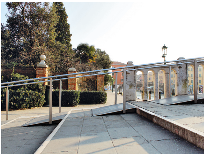
Fig.01 Ponte Papadopoli: vista delle pedane inclinate amovibili metalliche appoggiate sui gradini del ponte poste in opera nel 2014. I montanti, realizzati con due piatti di acciaio avvitati e agganciati alle pedane, sono collocati in corrispondenza dei "pieni" del parapetto originario in pietra d'Istria, e il corrimano, realizzato con tubolare in acciaio e sorretto dai montanti, segue perfettamente il disegno del parapetto. R.Revellini
