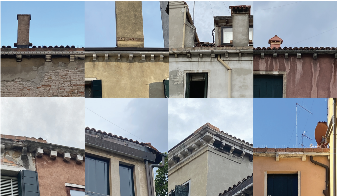
04. Architettura diffusa veneziana: variazioni delle trasformazioni dell'attacco al cielo, in relazione dell'aumento di portata d'acqua dei canali di gronda sommitali. Venetian traditional architecture: changes in the transformations in relation to the increase in water flow of the upper eaves canals. Greta Bruschi
