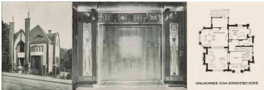
2 | Peter Behrens, Haus Behrens Darmstadt, Bühnentür zwischen Empfangsraum und Esszimmer, 1901.
