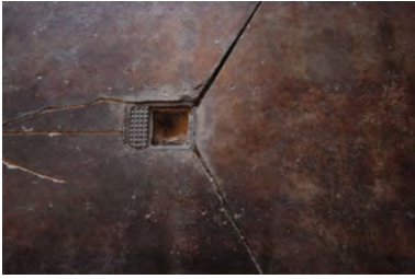
Zentral Sauna : scarico nel pavimento spaccato del locale docce. Foto: Guido Morpurgo.
