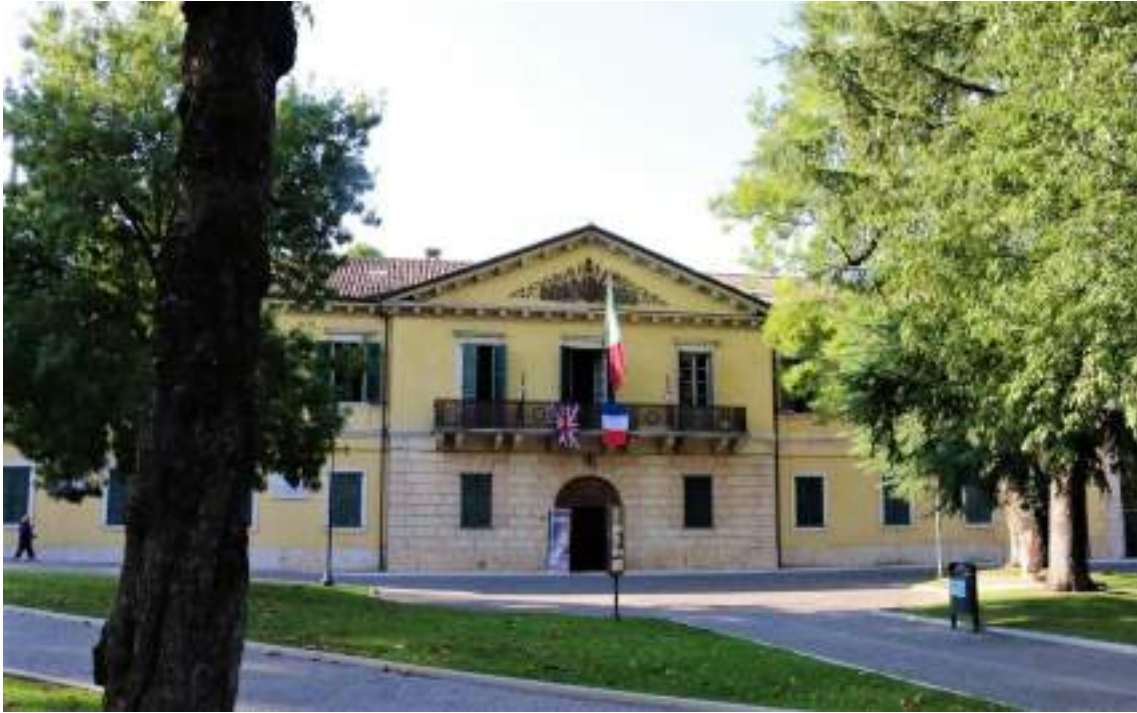
Figura 1. Ingresso e facciata del Palazzo del Comando di Piazzaforte, detto anche Palazzina Storica. Fonte: Fotografia di Monica Biasiolo, autrice (2021)
