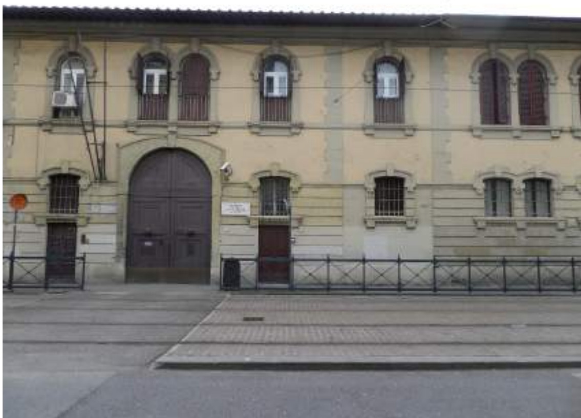
Facciata della caserma Morandi-Simoni di Firenze. Fonte: fotografia di Federico Camerin (2017).
