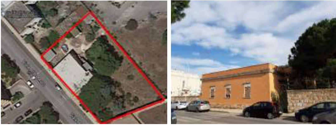
Figura 7. A sinistra vista aerea Alloggio ASI e a destra Prospetto viale Aldo Moro
