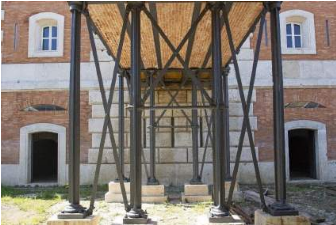
Figura 2. Forte Aurelia. Veduta del ponte dall'ingresso della Polveriera. Fonte: D. Sampalmieri – G. di F.
