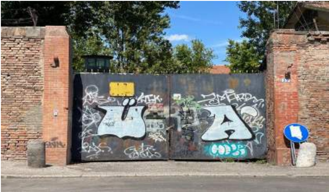
Figura 1 - Ex caserma Pozzuolo del Friuli: l'accesso secondario per i mezzi carrabili su via Scandiana, in prossimità di Palazzo Schifanoia. Fonte: Francesco Alberti (2021)
