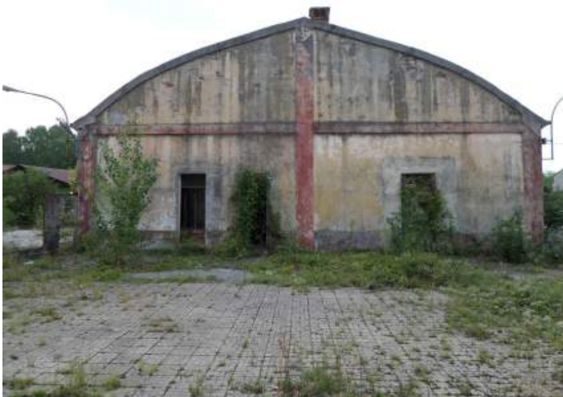
Edificio invaso dalla vegetazione all'interno della caserma Trieste di Casarsa della Delizia (Pordenone). Fonte: fotografia di Federico Camerin (2015) scattata durante il workshop internazionale Restarting from Bacchus and Dionysus, with the help of Oyamatsumi , DASTU-POLIMI.
