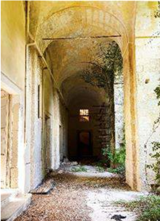
Figura 1. Stato attuale dell'interno della Caserma Cimarrusti a Lecce (corte principale). Fonte: Cristina Danisi (2020)
