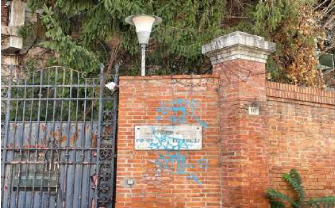
Figura 2 - Ex caserma Pozzuolo del Friuli: lo stato di abbandono e di degrado nella vista dell'accesso principale su via Cisterna del Follo. Fonte: Francesco Alberti (2021)
