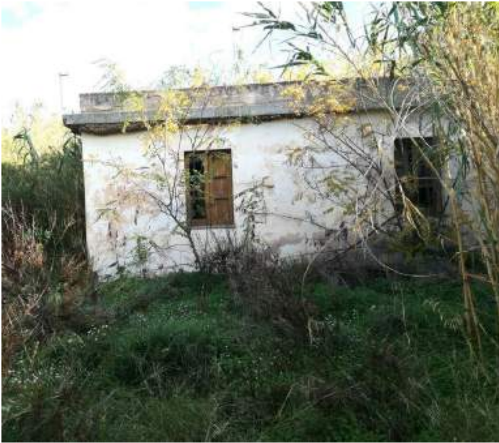
Figura 3. Fabbricato squadra antincendio. Fonte: Progetto esecutivo-relazione sulle interferenze (2018)
