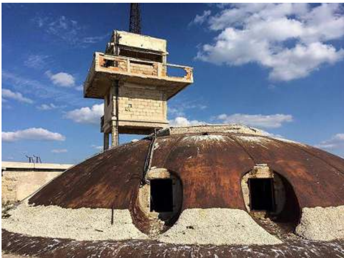
Figura 2. Foto della Cupola girevole Grüson sul Forte Umberto I. Fonte: foto degli autori (2017)
