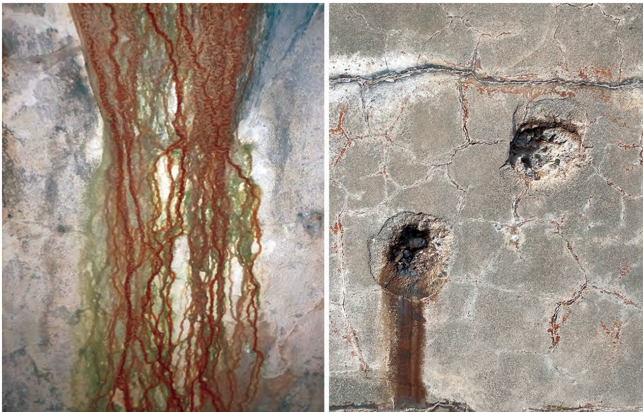
6: Forte Cosenz. A sinistra: colature, concrezioni e patine biologiche si sovrappongono sulle superfici intonacate degli interni. A destra: riprese di getto che emergono dagli intonaci fessurati e tracce di proiettili (Danesi, 2022).
