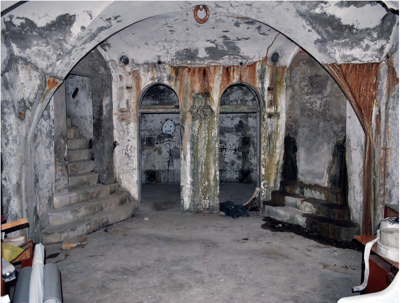
5: Forte Cosenz, atrio di ingresso. Al centro i due ambienti originariamente adibiti al deposito delle cariche, ai lati gli accessi alle sale di azionamento dei cannoni sulla copertura, di cui una tamponata (Danesi, 2022).
