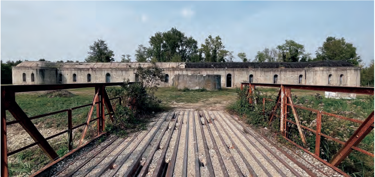
1: Forte Cosenz, l'ingresso all'area circondata dal fossato, attraverso il ponte di putrelle in ferro e riempimenti di ghiaia e terriccio. Si noti la cisterna circolare posta davanti al prospetto principale del forte, demolita nel dicembre 2022 (Di Resta 2022).
