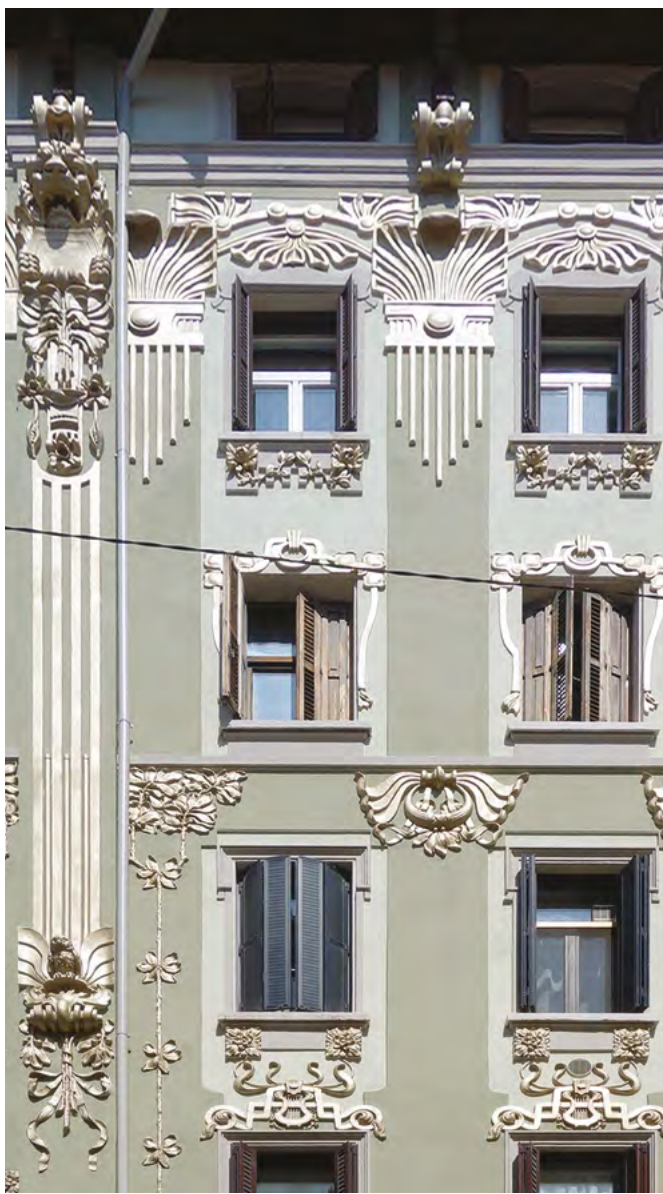
04-05. Palazzo residenziale in via Giulia 33, Trieste. Realizzato da G. M. Mosco e G. Righetti nel 1903. Fotografia dello stato attuale, 2024 | Residential building on Via Giulia 33, Trieste. Built by G. M. Mosco and G. Righetti in 1903. Photograph of the present condition, 2024. G. Danesi
