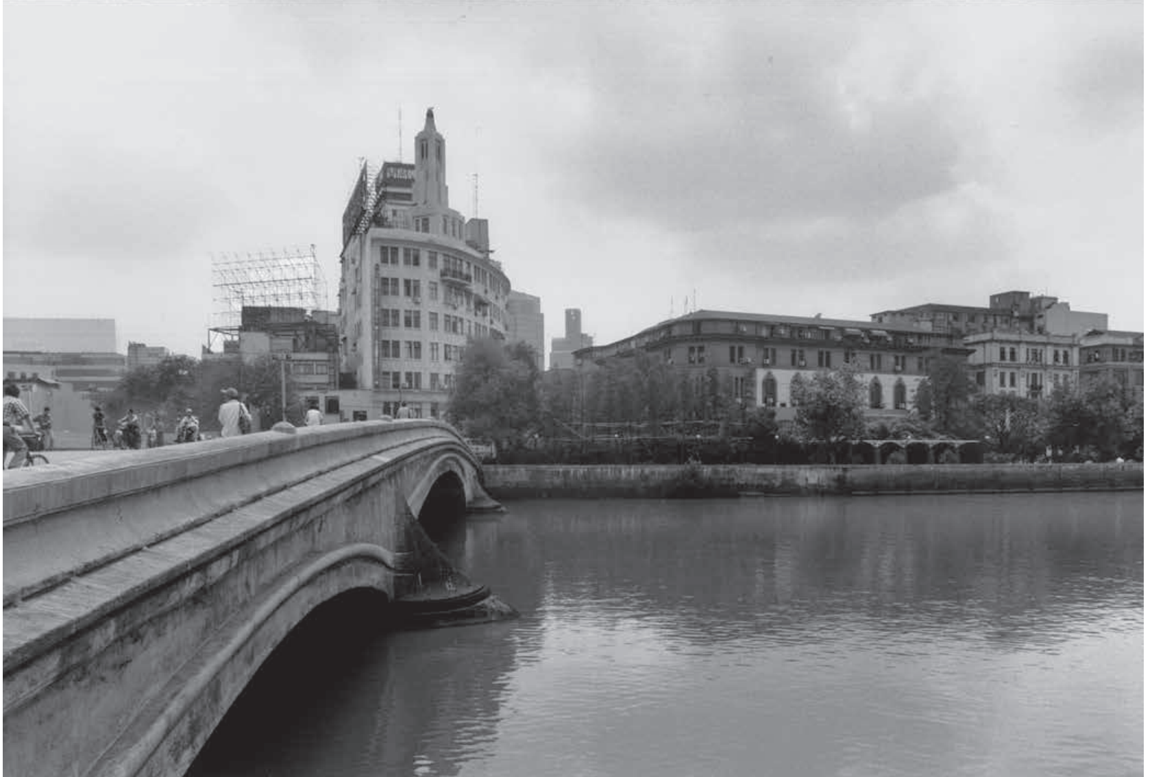
Il fronte nord di Waitanyuan affacciato sul Suzhou Creek era caratterizzato dall'isolato incompiuto del Capitol Theatre e dai vecchi magazzini allineati sul fiume. Ph. Guido Morpurgo, 2002.
