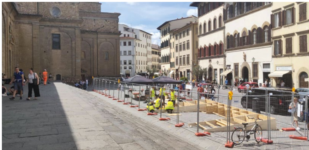
Fig.01 Fasi di costruzione durante il cantiere.
