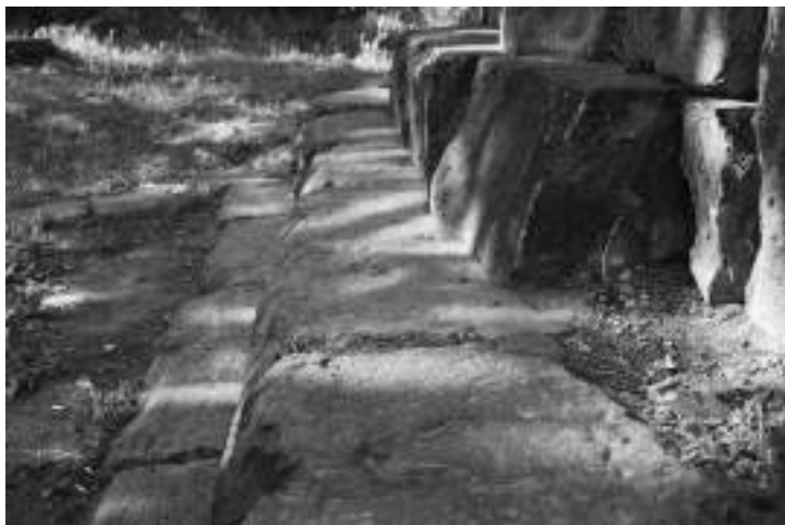
Fig. 5 Chiesa di Khumarajam a Garni, Armenia. Fotografia di dettaglio dei tre gradini della piattaforma basamentale di fondazione, o crepidine, in cui si nota la presenza del tracciato inciso di progetto, icnografia. Fotografia dell'autore, 2022.
