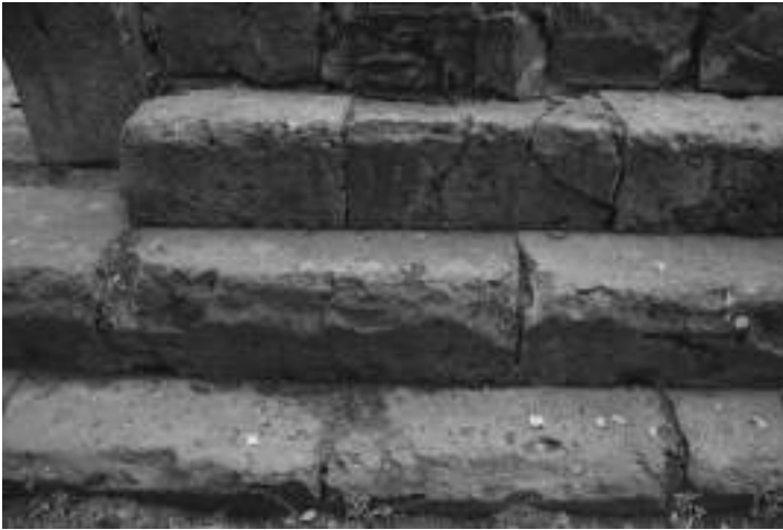
Fig. 4 Chiesa di Khumarajam a Garni, Armenia. Fotografia di dettaglio dei tre gradini della piattaforma basamentale di fondazione, o crepidine, in cui si nota l'alternanza bicroma dei conci e le loro grandi dimensioni. Fotografia dell'autore, 2022.
