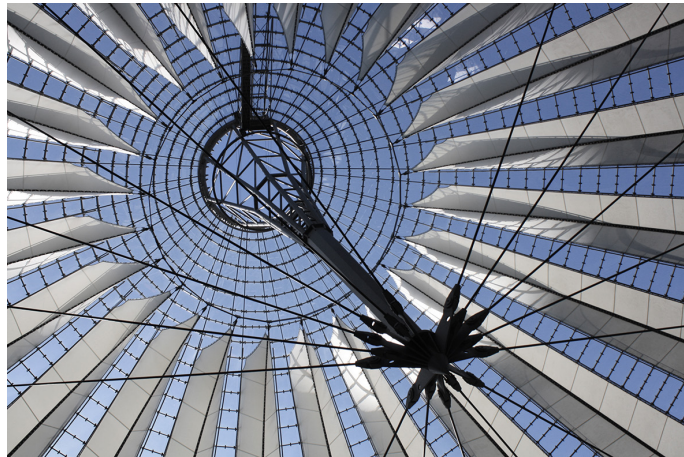
Fotografia. Vista al di sotto della copertura "a vulcano" di Potsdamer Platz, centro di attraverso e di connessione urbano a diversi livelli di infrastrutture.
