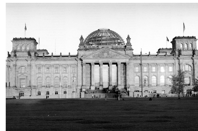
Fotografia. L'edificio in seguito ai restauri e alla costruzione della cupola, costituendo un esempio di innesto del nuovo nell'antico.
