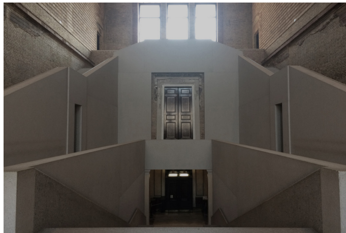
Fotografia. Lo scalone in seguito al progetto di Chipperfield, ricostruito in un unico materiale liscio nelle parti portanti e lasciato grezzo nel corrimano. Non viene ripristinata la loggia delle cariatidi.
