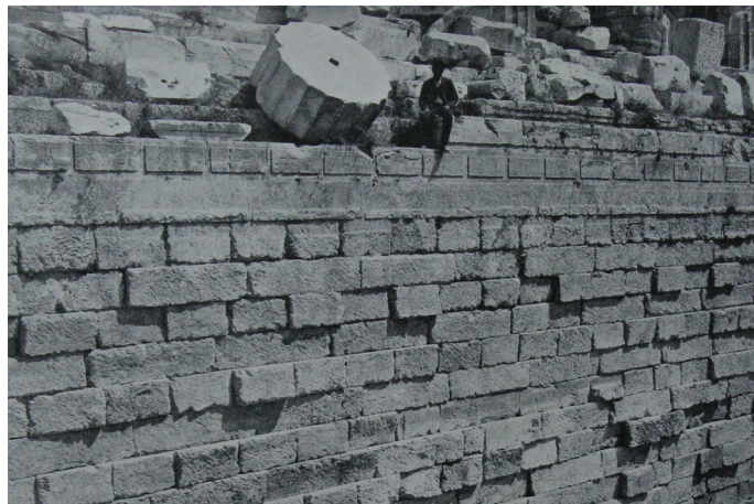
Fotografia. Il gigantismo delle fondazioni del Partenone, paragonato alle dimensioni umane.
