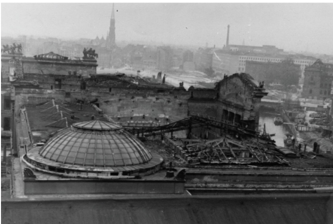
Fotografia. La copertura crollata del Neues Museum recò notevoli problemi alla collezione interna, che dovette essere trasportata altrove.
