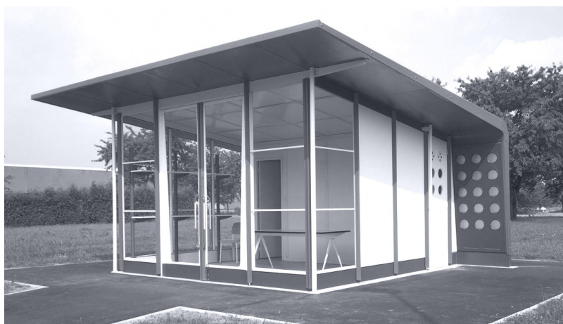
Andrea Marchetti. Stazione di servizio prefabbricata Shell, tipo B. 1948 ca.
