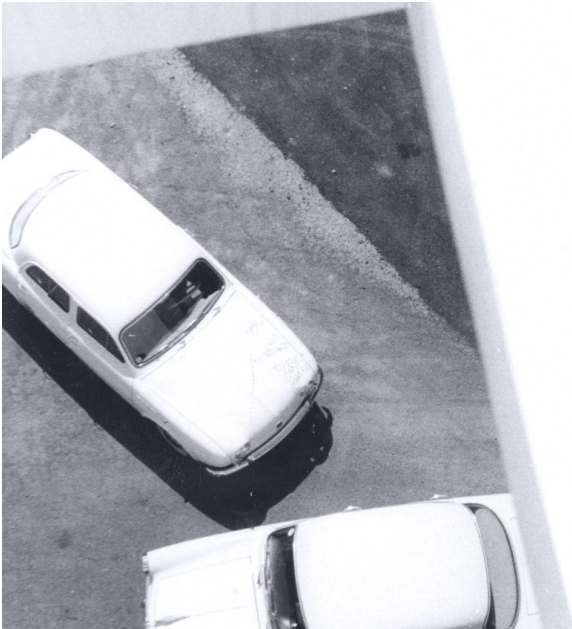
Stazione di servizio e Motel Agip a Catania. Fotografia di Federico Patellani. 1959. Archivio Storico Eni.
