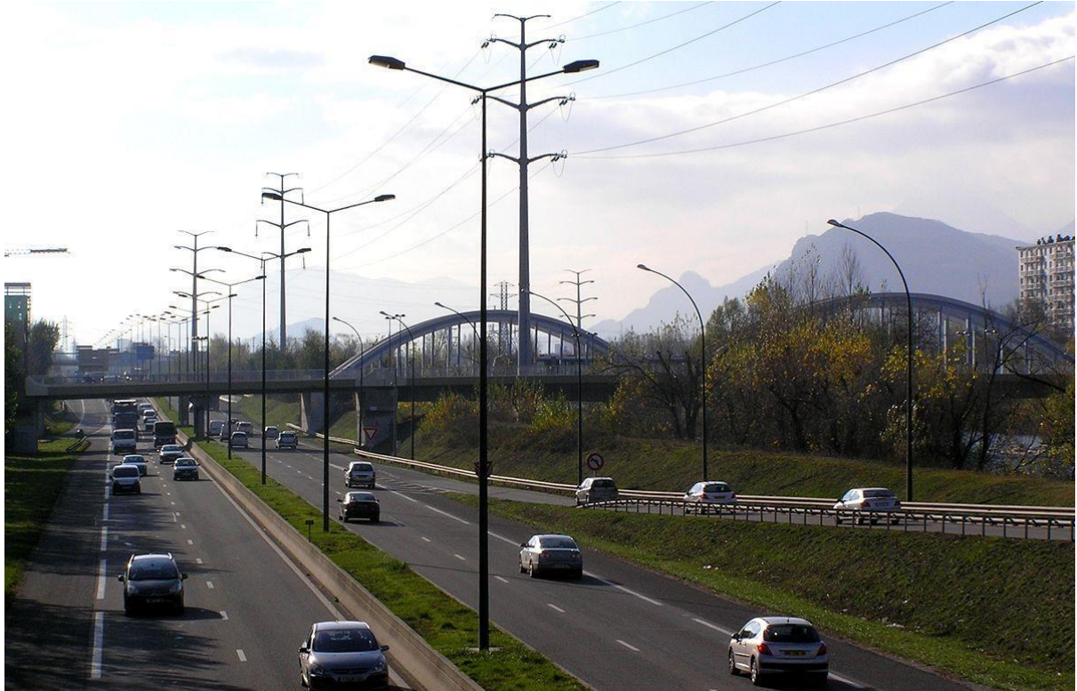
Fig. 44 Grenoble, 2016, immagine della passerella pedonale che passa sopra l'autostrada e i binari della ferrovia.
