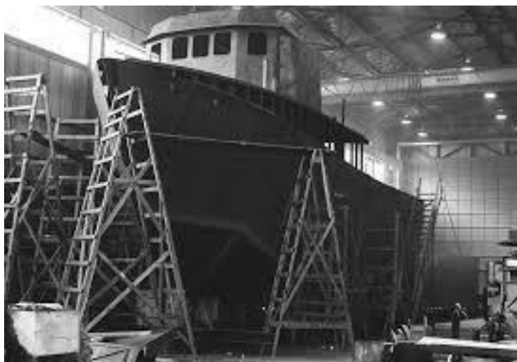
Fig. 39, Barry Truax, il cantiere navale che ha ispirato il brano Earth and Steel
