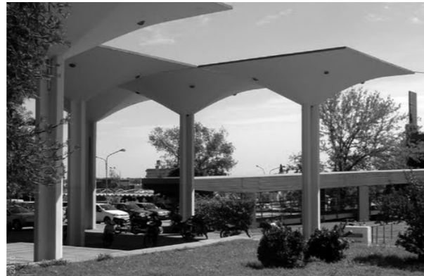
Clorindo Testa, Centro Civico di Santa Rosa a La Pampa, 1958-65. Copertura esterna a elementi modulari.
