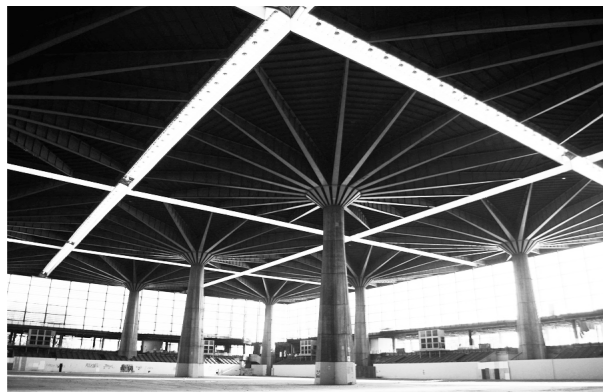
Pier Luigi Nervi, Palazzo del Lavoro a Torino, 1959. Elemento modulare con copertura a base quadrata.
