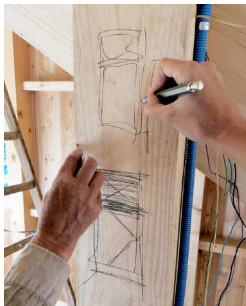
Modelli in polistirolo, gesso e cemento nello studio Caminada a sinistra. A destra Gion Caminada e l'architetto Tommaso Arnaboldi disegnano in cantiere
