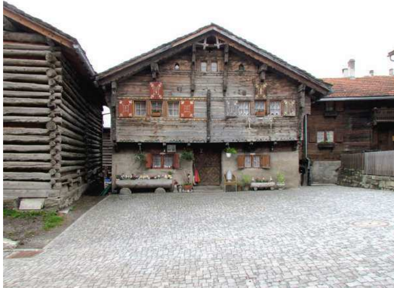
Vrin. Edificio bifamiliare del 1753
