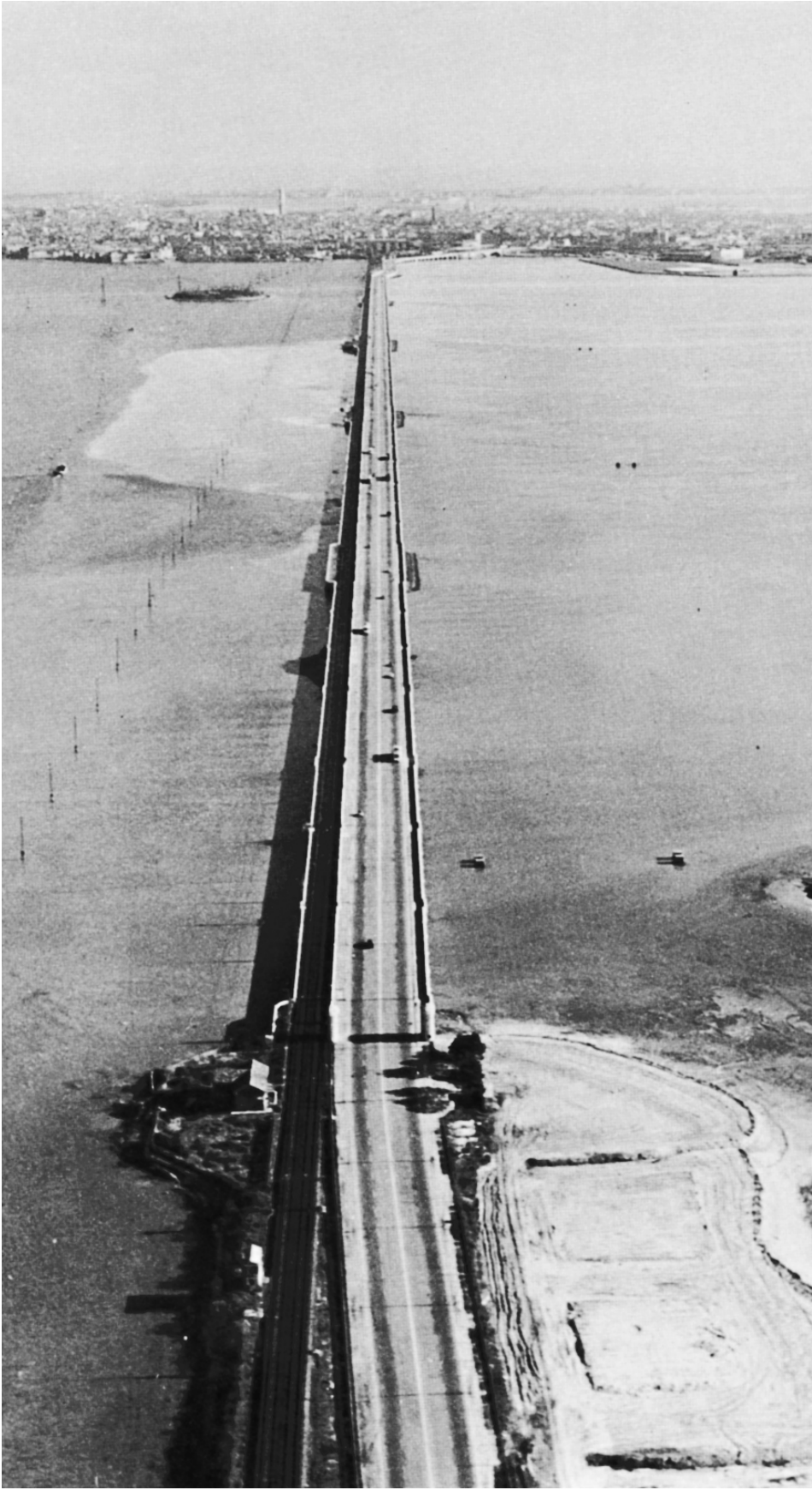
Fotografia del ponte translago di collegamento tra Mestre e Venezia (sullo sfondo).
