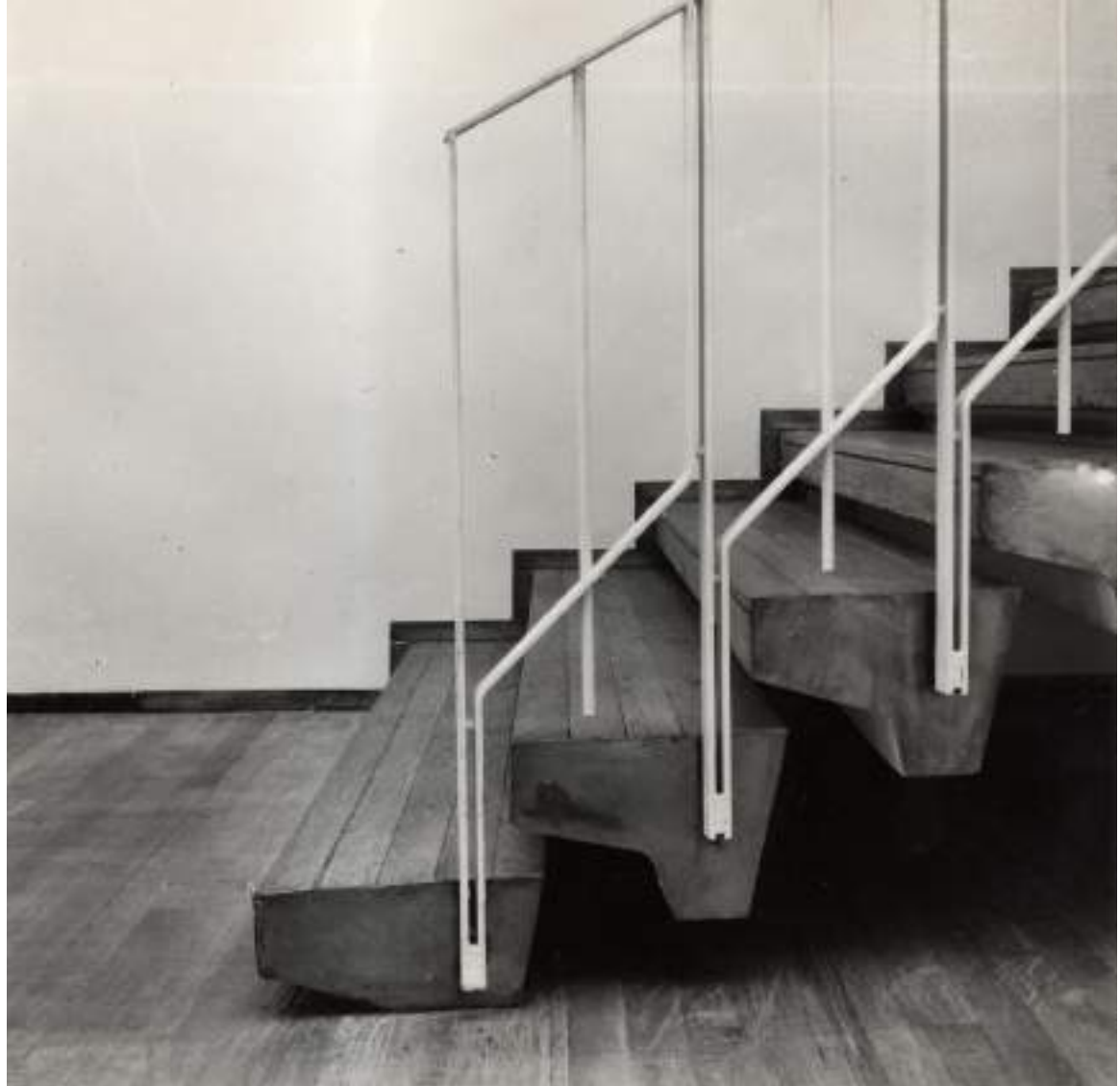
Scala. Dettaglio dell'attacco dei primi gradini al piano della galleria. Fotografia, G. Casali. ASG A destra: disegni di studio della scala e della ringhiera. CSAC
