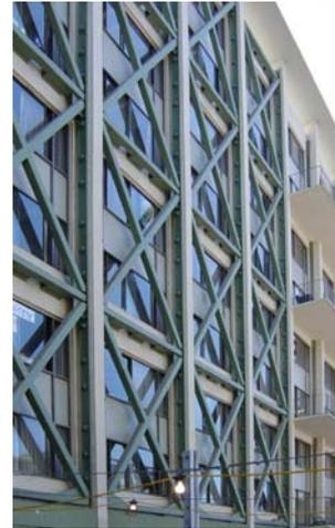
**Figura 1** – Berkeley University, USA; dormitory; 2005. Uno dei primi esoscheletri per la prevenzione sismica.
