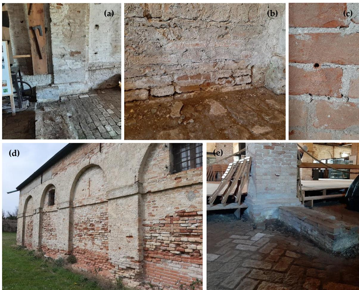
Figura 71. Stato di conservazione del Teson Grande durante i monitoraggi eseguiti nel 2021/2022: (a) e (b) parete perimetrale, (c) foratura del giunto di malta per determinazione MC%, (d) esterno, (e) base di un pilastro portante interno.
