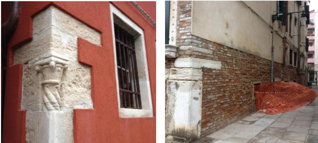
Figura 29. A sinistra, intonaco macro-poroso che altera la percezione delle modanature in facciata; a destra, rimozione dell'intonaco nella parte basamentale dell'edificio.
