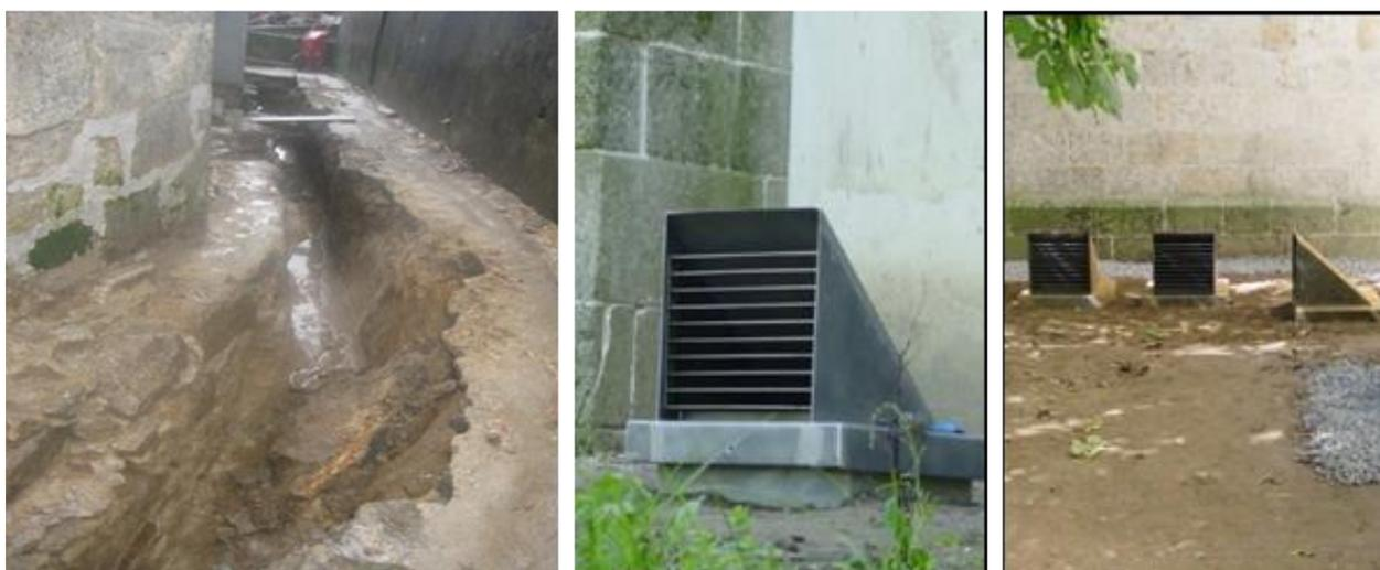
*Sistema di drenaggio (a sinistra) e bocchette di ventilazione (destra)*
