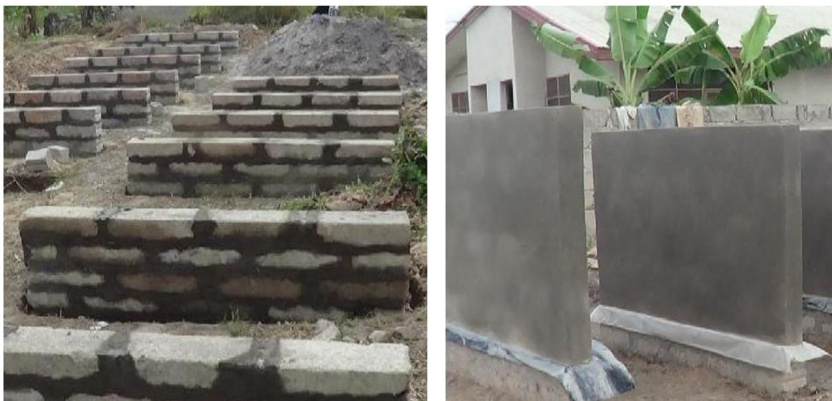
*Modelli di muratura con blocchi in calcestruzzo a vista (sinistra) e con rivestimento impermeabile (a destra)*
