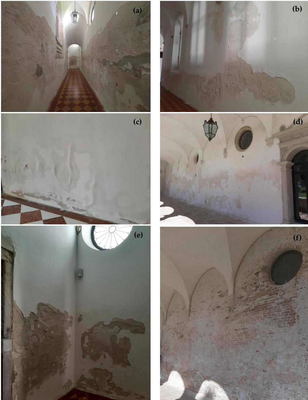
Figura 82. Immagini dello stato di conservazione di parte dell'Abbazia di S. Giorgio Maggiore ((a) e (b) corridoio, (c) distacchi nella muratura interna della Sala Capitolo, (e) applicazione sistema di trattamento passivo) e Chiostro del Buora ((d) muratura intonacata e (f) rimozione degli intonaci – intervento Settembre 2023).
