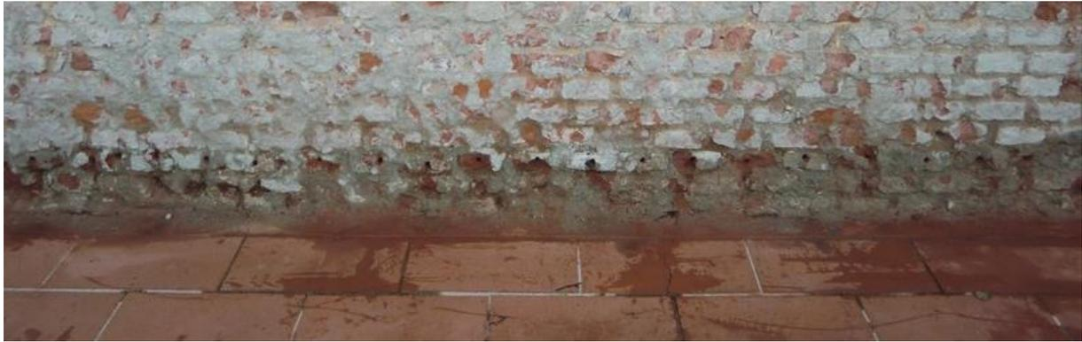
Figura 9. Esempio di foratura alla base della muratura per eseguire iniezione/impregnazione di prodotti chimici.
