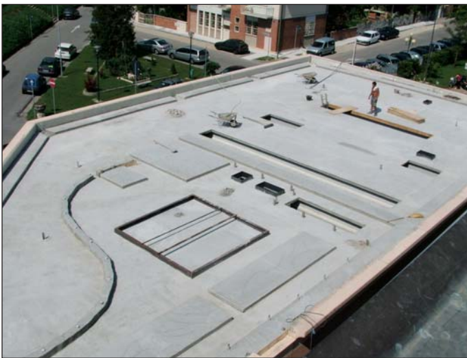
Veduta dall'alto della copertura in corso d'opera.
