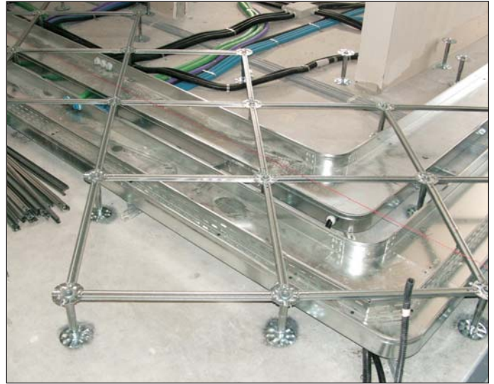
Particolare della posa del pavimento galleggiante.
