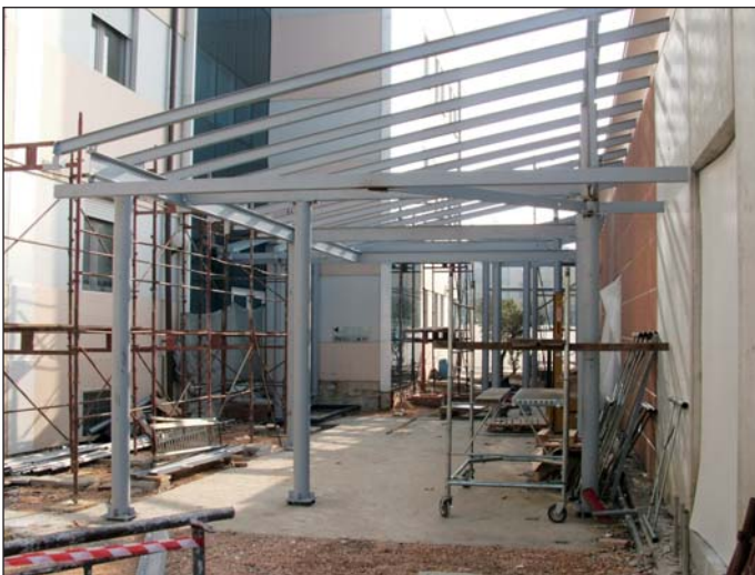
Montaggio della struttura metallica della hall di ingresso.
