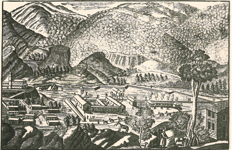
A Fonderie des Mines fines, et des Matras du Cuivre B Fonderie de Séparation C Logemens et magasins D Boccommes E Canal des Fontes F Salle d'affinage G Magasin du Charbon pour les mines H Magasin de Charbon pour les sépara- tions I K L Bâtimens pour les calcinations M Chaussée Canal N Porte d'entrée O Puits d'eau de la Sesia P Avant Chaussée Q Paroisse de Scopel R Le Village S Chemin des mines d'Allagne T Lavage de la Bascarelle aux mines de Sessera
