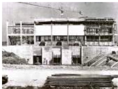
Agosto 1971. Costruzione dell'idrovora di Valle Tagli.
