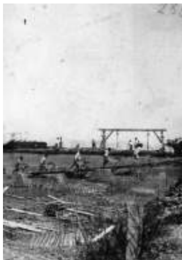
1920. Stato dei lavori di costruzione del sistema dei canali agricoli.
