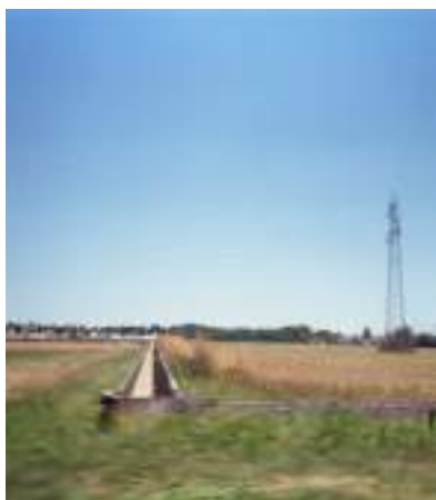
Veneto. Sisema di canalizzazioni agricole in cemento. Camilla Cangiotti, 2020.
