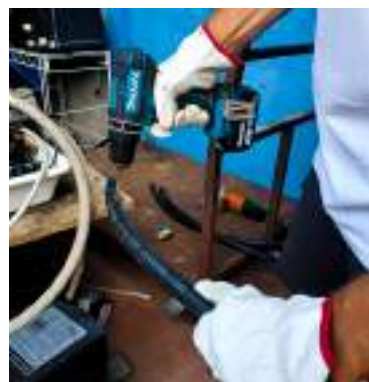
Costruzione del sistema di drenaggio per gravità. Taglio dei tubi in PVC e foratura.
