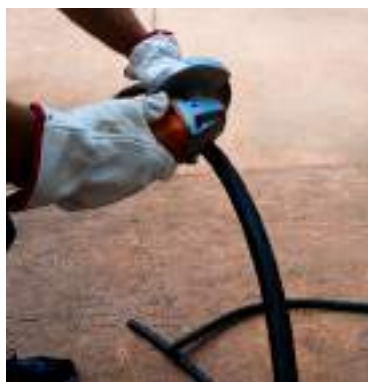
Costruzione del sistema di drenaggio per gravità. Taglio dei tubi in PVC e foratura.
