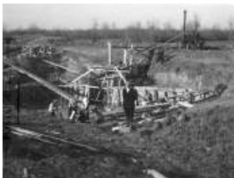
1927. Scavo per la fondazione della spalla destra del ponte sul canale Melgher.
