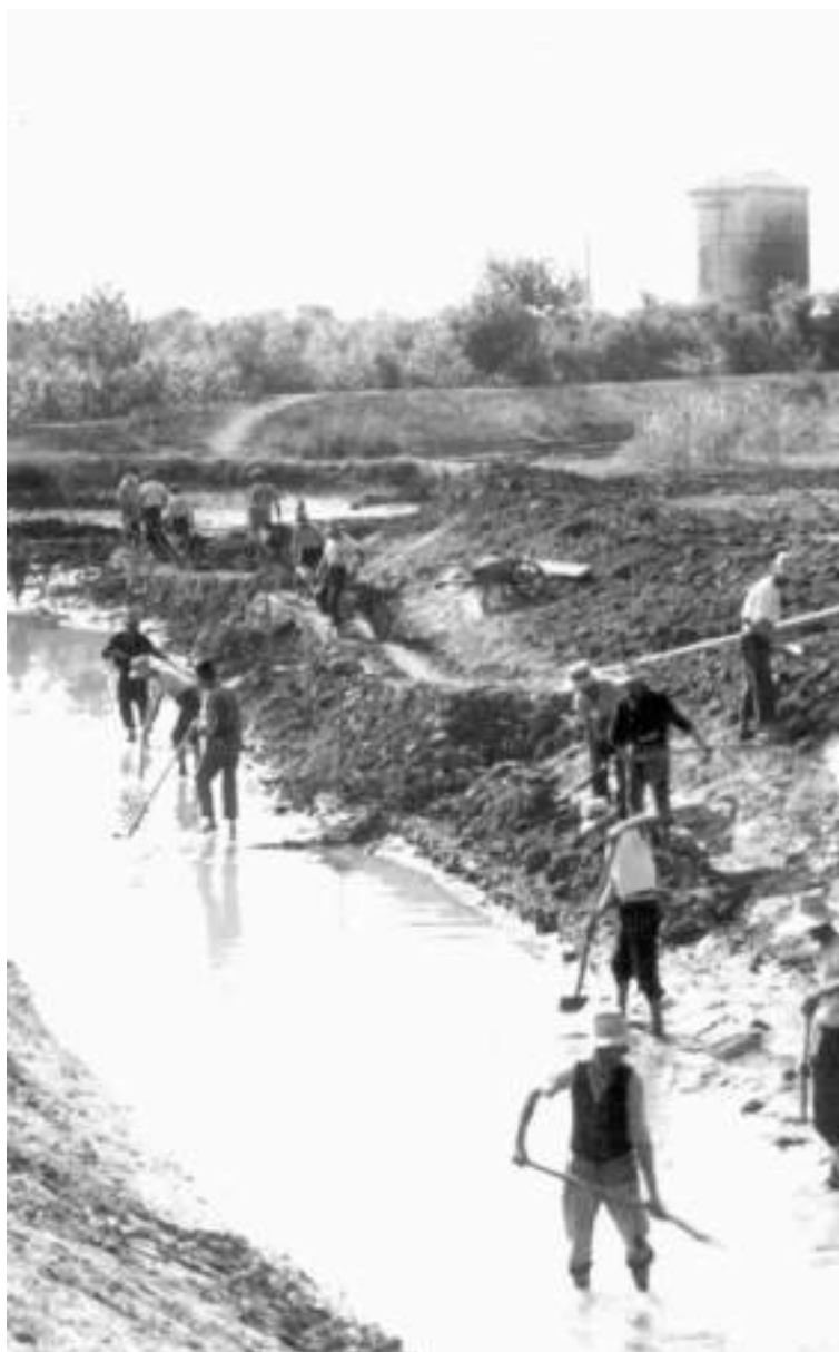
Badilanti durante l'escavo di un canale. Fonte: Archivio Consorzio di Bonifica Veneto Orientale
