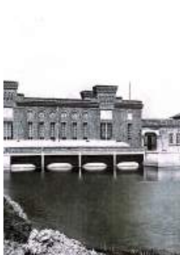
L'impianto idrovoro di Cà Corniani.
