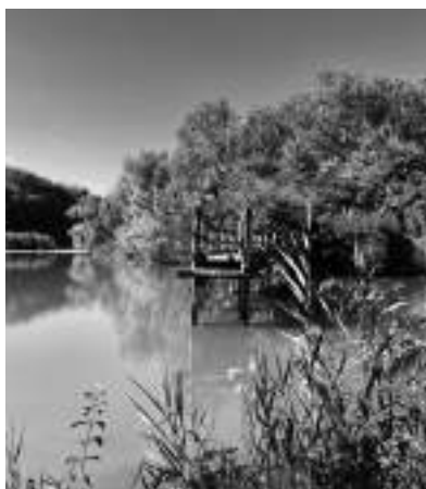
Oasi Cà di Mezzo. Manufatto sul terzo bacino. A causa della scarsa manutenzione oggi il ponte non è più agibile.
