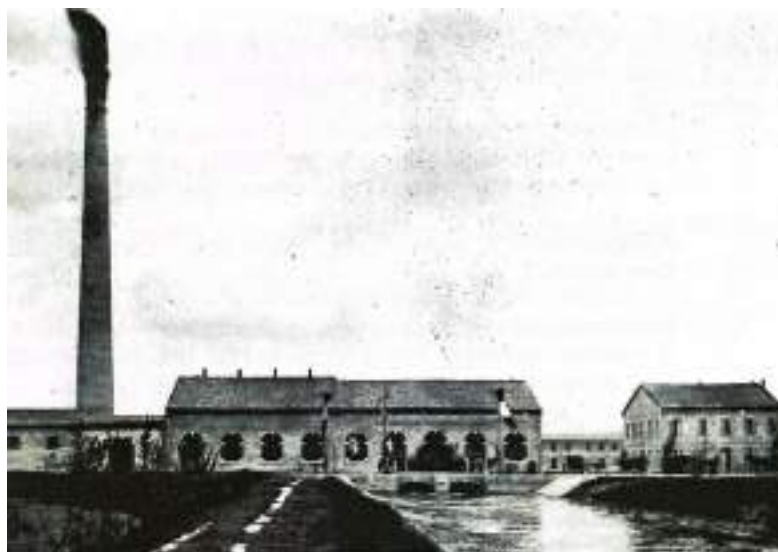
1903-1907. Inaugurazione dell'impianto idrovoro di Cavazuccherina. Cominciò a prosciugare il comprensorio nel 1907; nel Dicembre 1909 le opere (canali, strade, manufatti, idrovora) furono dichiarate ultimate.
