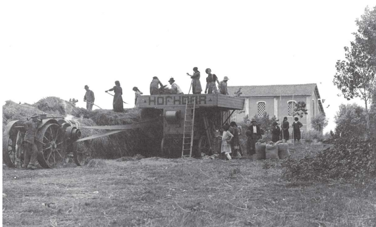
Trebbiatura con motore a scoppio. Trattrice Titan. La trattrice è un veicolo semovente a ruote o cingoli utilizzato in agricoltura per trainare o azionare attrezzature agricole come aratri, spandiconcime o rimorchi.
