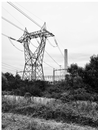
Dettaglio della ciminiera alta 250 m e più elevata opera in muratura d'Italia. In primo piano la natura si sta riappropriando dell'area dismessa.
