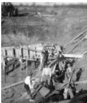
1927. Scavo per la fondazione della spalla destra del ponte sul canale Melgher.
