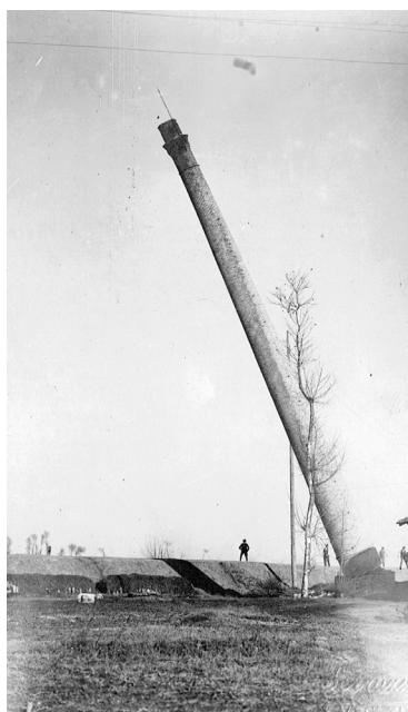
Fine della bonifica privata. Si abbatte la ciminiera di Cittanova.
