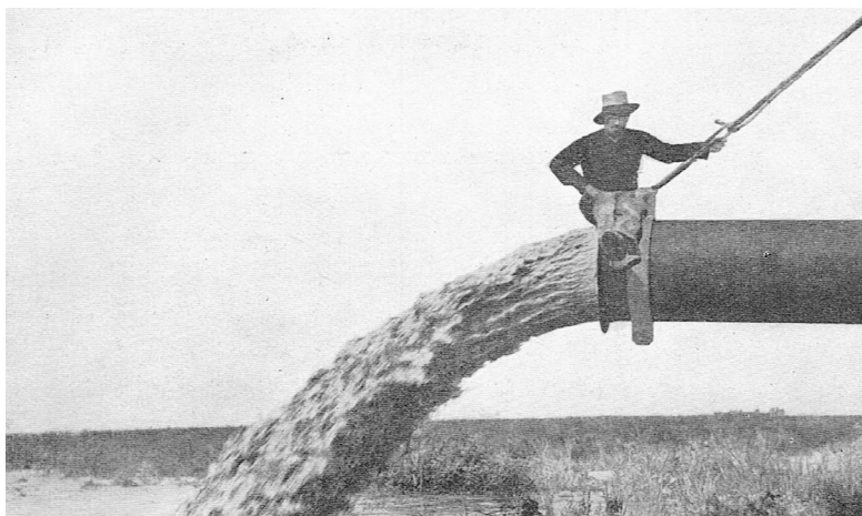
1919. Sistemazione del Canale Brian. Getto a distanza del materiale dragato.
