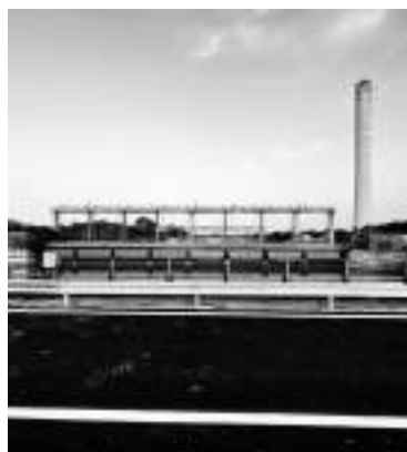
Impianto di trattamento o depurazione delle acque. È caratterizzato da una serie di vasche o bacini con strutture metalliche sopra di essi, che fanno parte di un sistema di filtrazione o sedimentazione.
