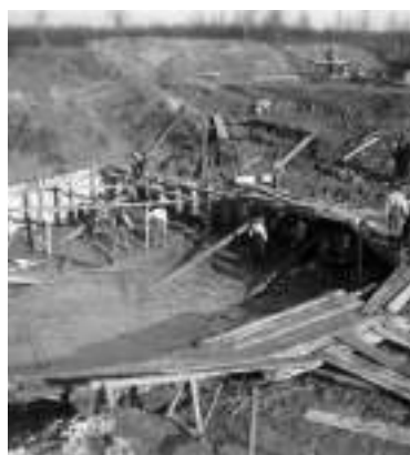
1927. Lavori di alzamento di livellata ed ampliamento di luce al ponte sul canale Malgher al chilometro 47.980 della linea Mestre-Portogruaro.
