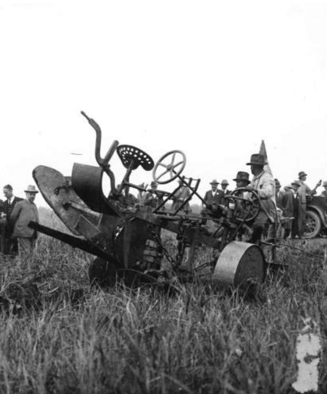
Il diadamento della palude con apparecchio funicolare. Fonte: Archivio Consorzio di Bonifica Veneto Orientale
