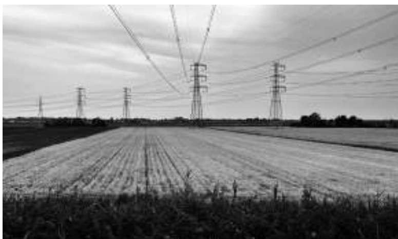
Il paesaggio del Petrolumscape. Tra i campi agricoli si ergono enormi tralicci un tempo utili a distribuire l'energia prodotta dalla centrale termoelettrica di Porto Tolle.
