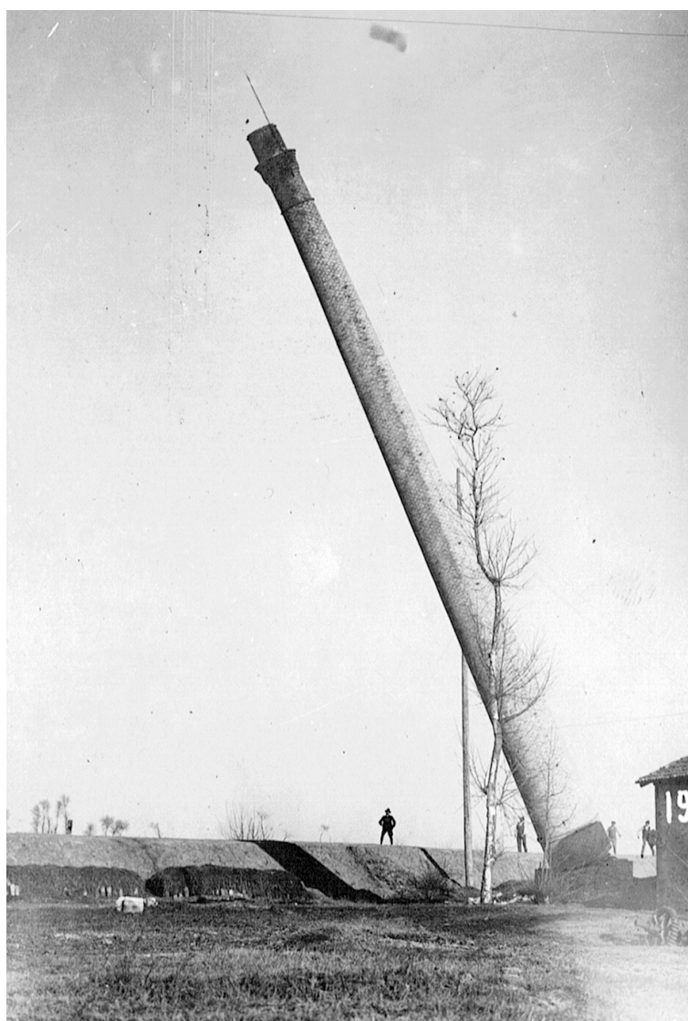
Demolizione della ciminiera di Cittanova. Fonte: Archivio Consorzio di Bonifica Veneto Orientale
