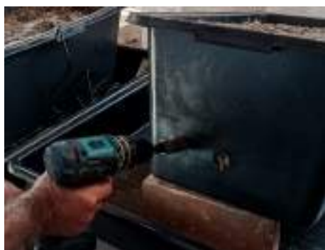
Costruzione del sistema di drenaggio per gravità. Foratura del vaso.
