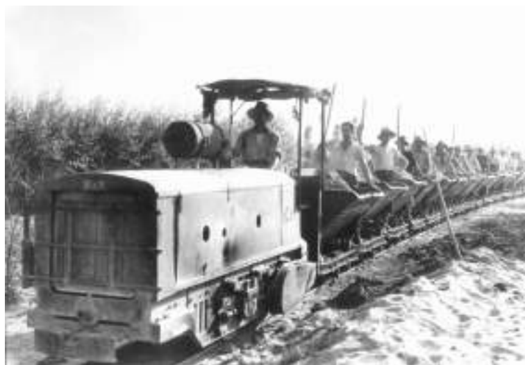
1929. Da un documento del Consorzio di Bonifica di San Vito al Tagliamento (1.10.1929) sulle opere complementari di bonifica idraulica si testimonia che i carriolanti trasportavano tramite binario le ghiaie utili all'inghiaimento delle strade interne al bacino.
