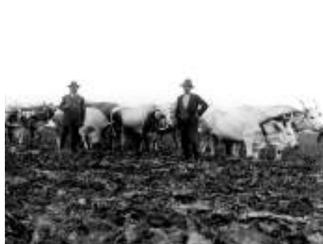
Dissodamento della palude mediante l'utilizzo di buoi. Le difficoltà maggiori erano rappresentate dalla poca consistenza del suolo e dalla necessità di ottenere un buon pareggiamento della superficie che consentisse di attendere la graduale formazione dello strato vegetale.
