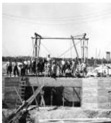
1915. Conca per l'ingresso delle barche nel Consorzio di scolo Ongaro Inferiore a Tre Cai (Grisolera)
