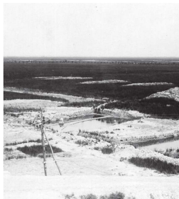
Anni '20. Inizio prosciugamento della palude e delle zone incolte vicino a Torre di Fine. Solo nel 1924, con la legge Serpieri, e poi nel 1928, con quella sulla Bonifica Integrale, hanno cominciato a prender consistenza i sussidi dello Stato per tali trasformazioni.
