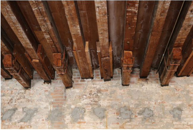
Fig. 2. Venezia, interno di un edificio con visibili trasformazioni e interventi di consolidamento che hanno interessato sia il sistema di orizzontamento ligneo (travi del solaio interpiano) sia le murature portanti. L'analisi stratigrafica può chiarire le manifestazioni di degrado e dissesto in rapporto alla cronologia delle parti (foto I. Zamboni 2022).
