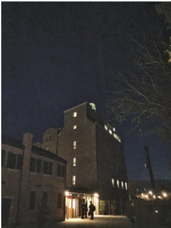
Fig.04 Vista della lanterna in sommità del silos degli ex mulini Passuello: a sinistra vista della lanterna che racchiude l'extracorsa oltre la copertura dell'edificio.
