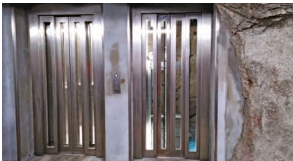
Fig.02 Le porte di piano Wittur installate all'arrivo dei due ascensori.
