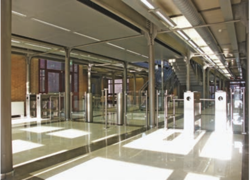
Fig.03 Hall di ingresso degli edifici sede dei Dipartimenti. In questo spazio del collettivo "ibrido", la componente tecnologica delle strutture e dell'ascensore è esplicitata per sottolineare la specificità di questo spazio attraverso l'uso dei materiali e delle componenti tecnologiche sottolineando l'innovativa, flessibile, multiforme, dinamica e leggera tecnologia della macchina interna.
