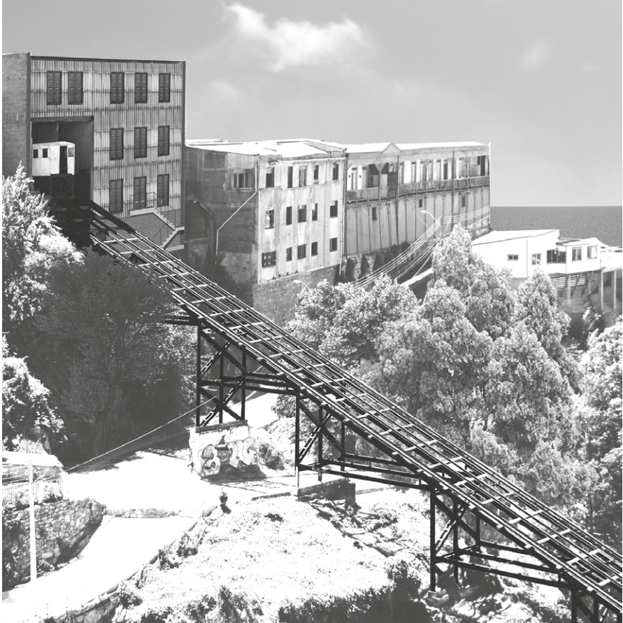
Fig.03 Nuova immagine dell'Ascensor Villaseca di Valparaíso come apparirà al termine dei lavori di riqualificazione, previsto per il 2020.
