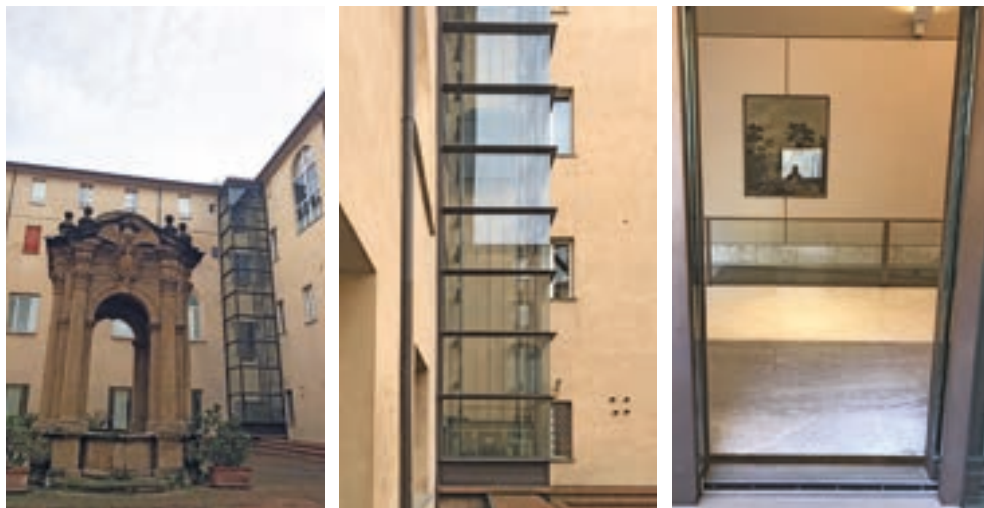
Fig.01 - 06 Dettagli del nuovo ascensore della Pinacoteca. thyssenkrupp Elevator BBNI
