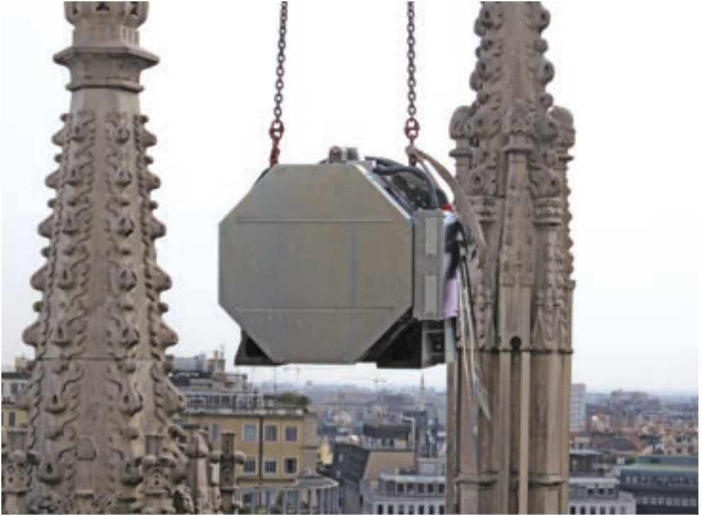
Fig.05 Fase di installazione tra le guglie del Duomo. Schindler Italia
