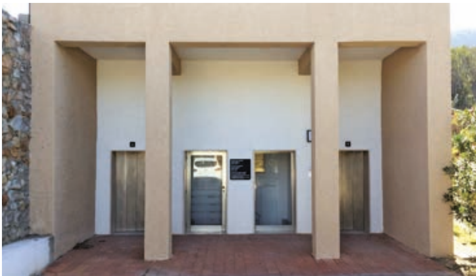
Fig.06 L'accesso ai nuovi ascensori.
