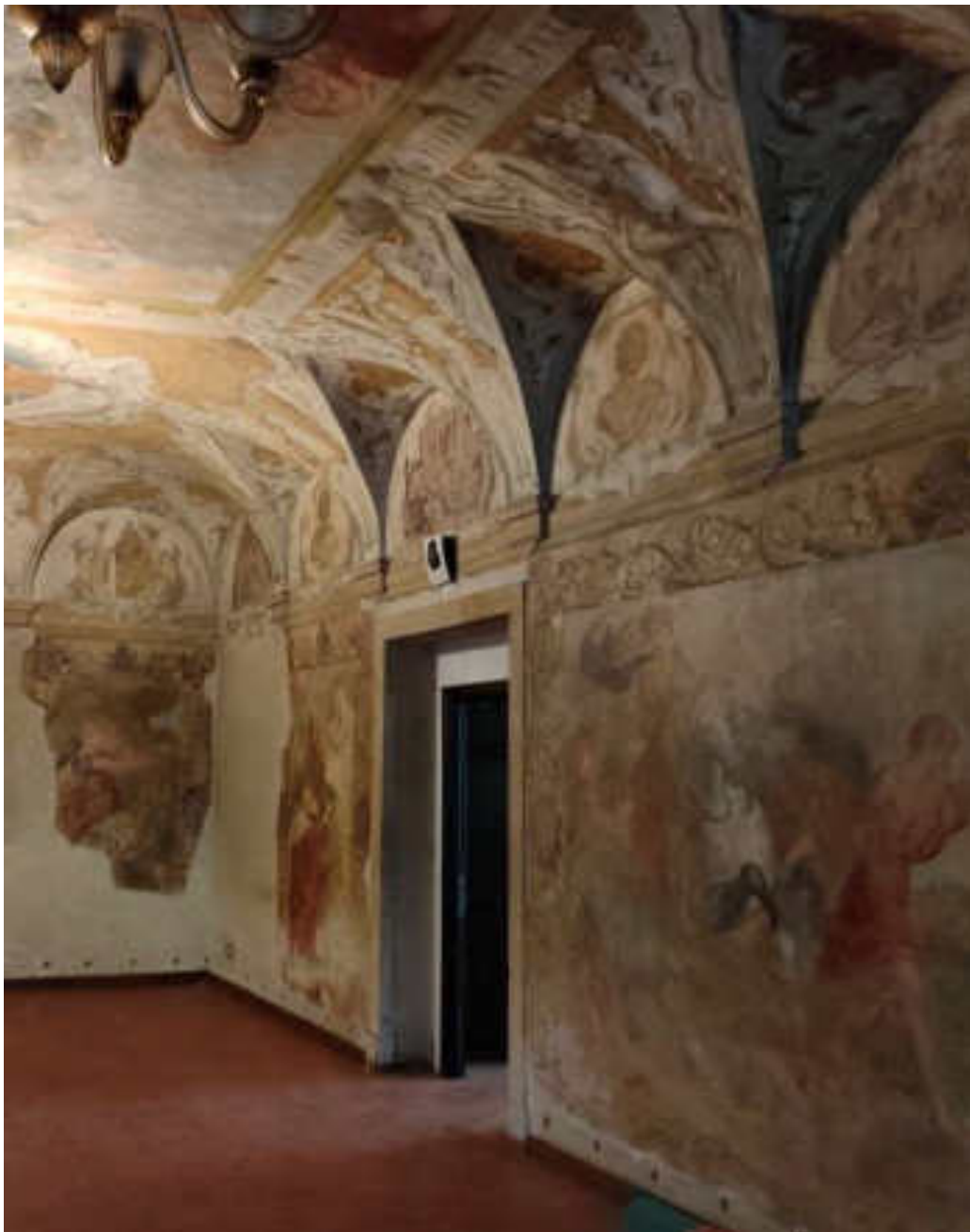
Fig. 5 | Il salone al piano terra della porzione Rova che verrà trasformato in sala studio (immagine degli autori)
