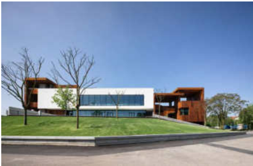
Fig. 9 | La “Collina degli studenti” edificio polifunzionale destinato al lavoro, lo studio, la socializzazione, il tempo libero. Veduta frontale (ph. Marco Introini)
