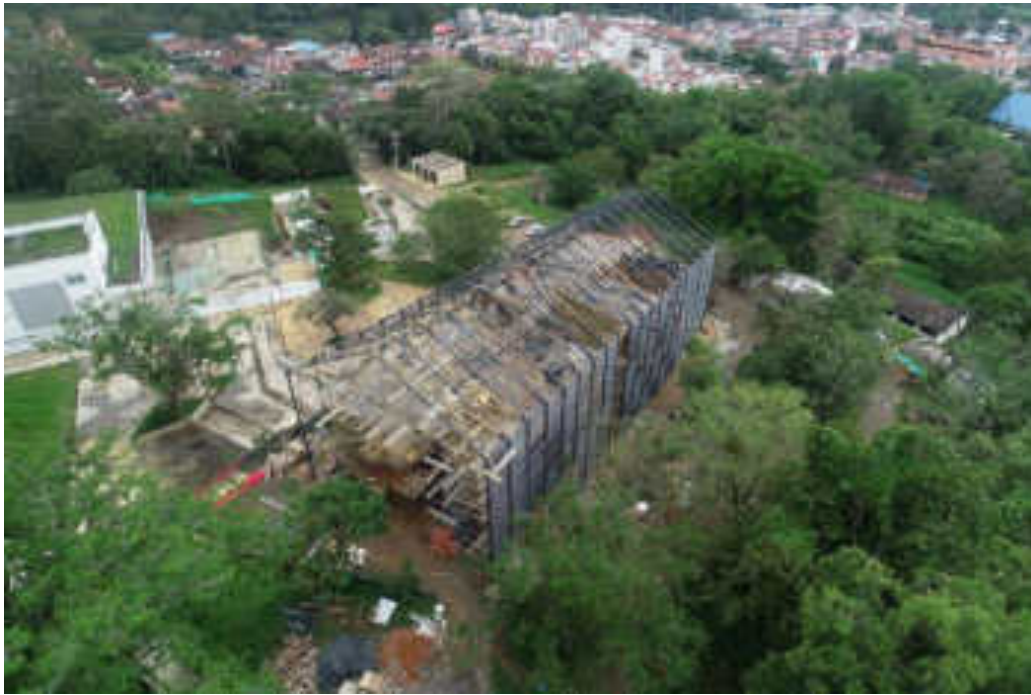
Fig. 3 | Edificio in costruzione. Vista dal drone (UIS, 2019).
