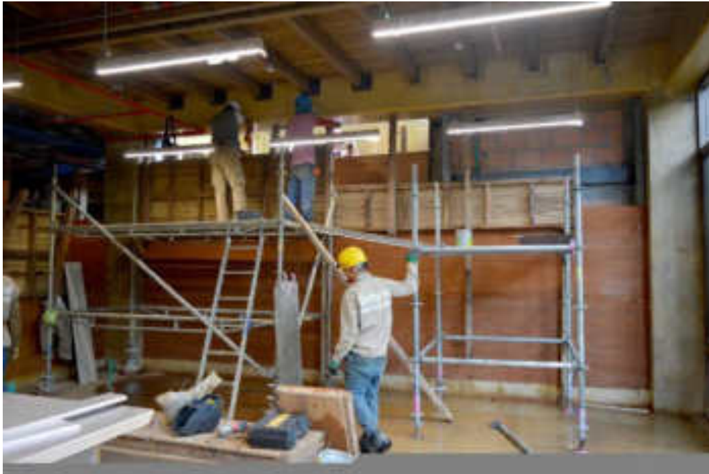
Fig. 4 | Realizzazione di una parete con la tecnica della tapia pisada (UIS, 2019).
