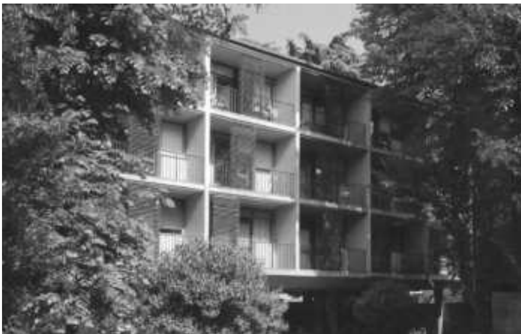
Fig. 3 | il fronte sul giardino dell'ampliamento dell'ingegnere Brunetta (Università degli Studi di Padova)
