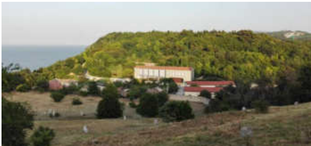
Fig. 3| Intervento B – Progetto di Ristrutturazione ed Ampliamento dell'Ex Deposito Derrate Esercito Italiano da adibire a Residenza per Studenti dell'Università Politecnica delle Marche.
