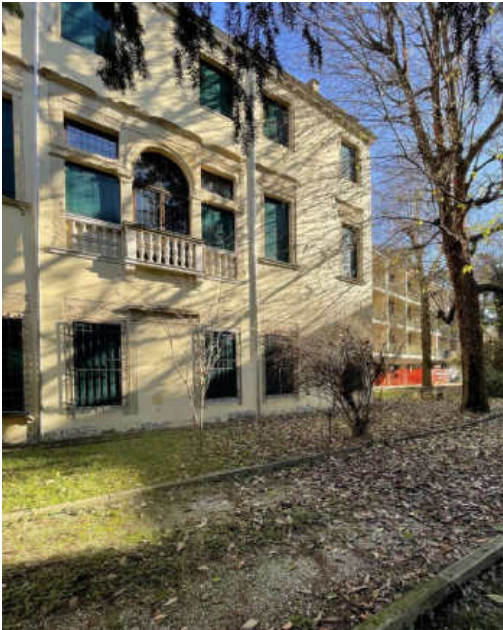
Fig. 2 | Palazzo Mocenigo-Querini (porzione Fabbro) e l'ampliamento novecentesco dal giardino di pertinenza (immagine degli autori)
