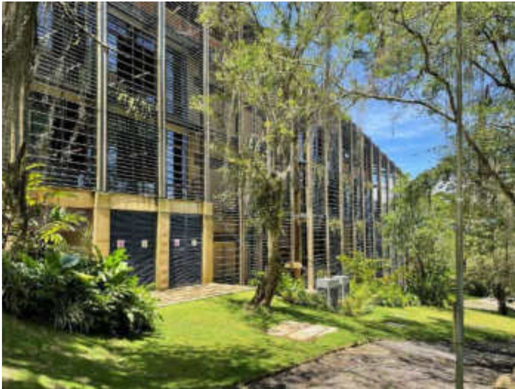
Fig. 9 | Fronte laterale permeabile e accessibile. (Luca Marzi, 2022).
