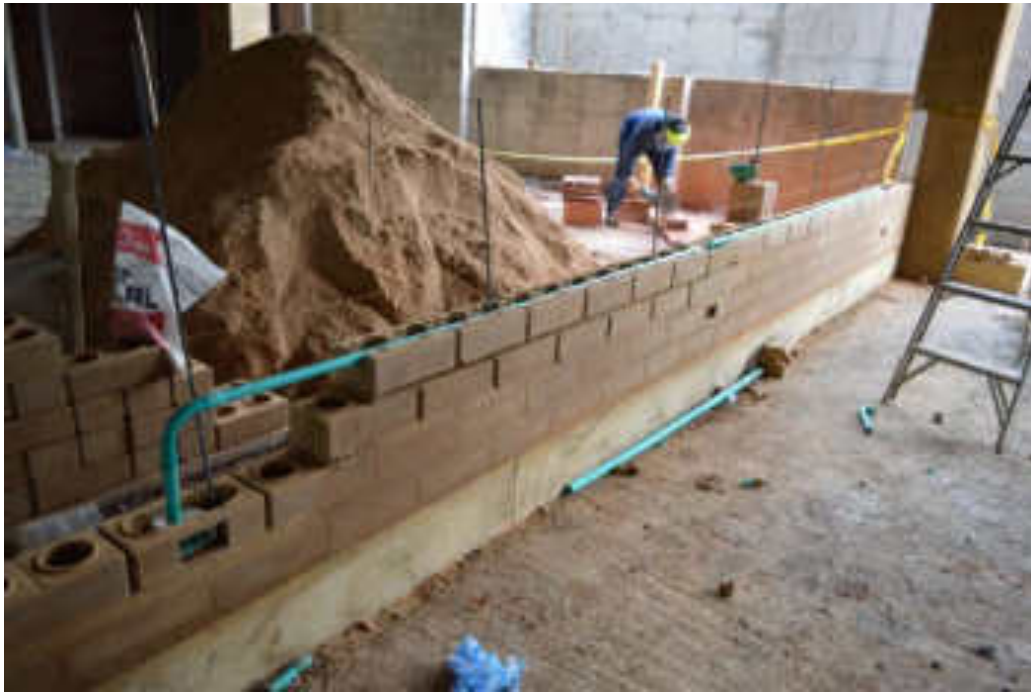
Fig. 8 | Parete in BTC sagomati per il passaggio degli impianti e delle armature. (UIS, 2019).
