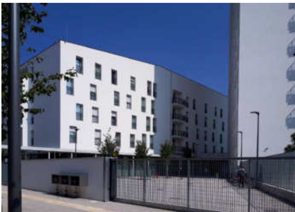
Fig. 5 | Residenza Pareto: il blocco residenziale. (Fonte: Archivio Centro TESIS)
