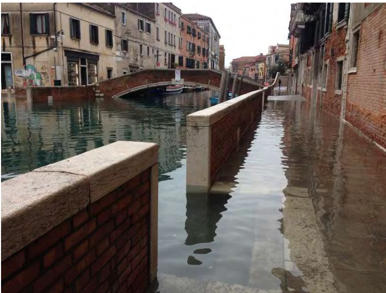
Fig. 3. Venezia, canale dei Carmini, allagamento da acqua alta che, insieme al degrado da umidità di risalita, correlato ai cicli salini, rappresenta una minaccia per il patrimonio costruito (foto A. Squassina 2015).
