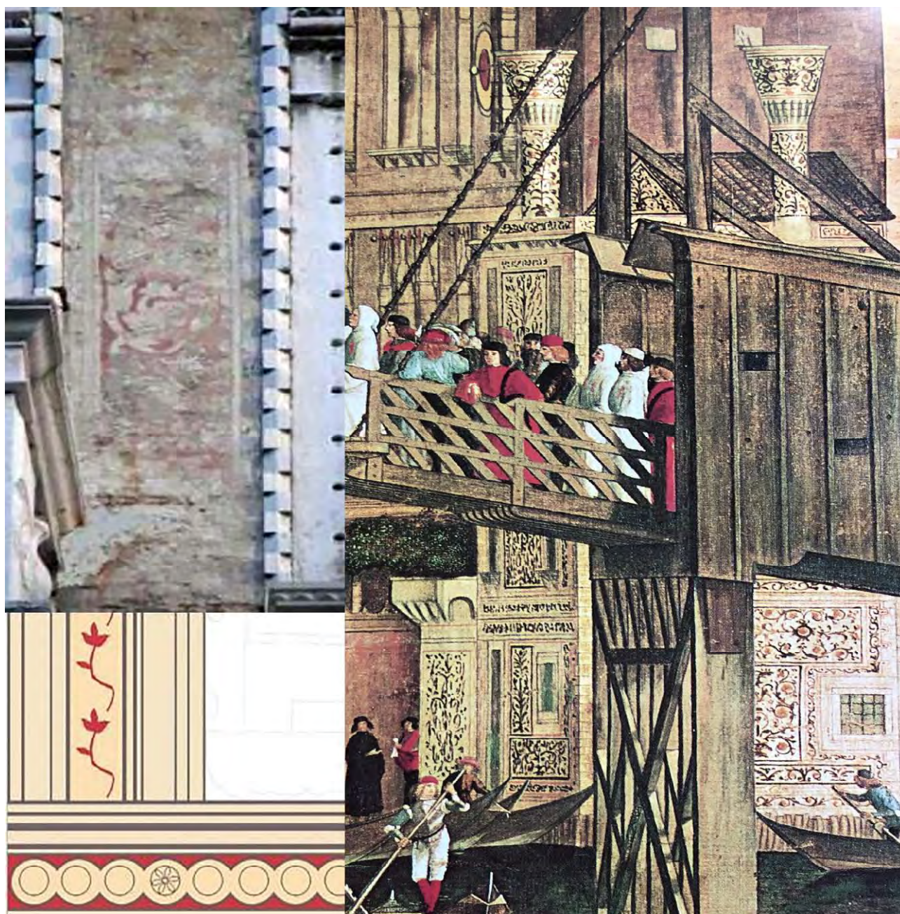
Fig. 1. Venezia, Frammenti: frammento di finitura policroma medioevale con motivo fitomorfo, raffrontato con un disegno ricostruttivo e con un dettaglio dipinto tratto da Vittore Carpaccio, Miracolo della reliquia della Croce al ponte di Rialto , 1494-95 (Venezia, Gallerie dell'Accademia, elaborazione di A. Squassina, 2023).
