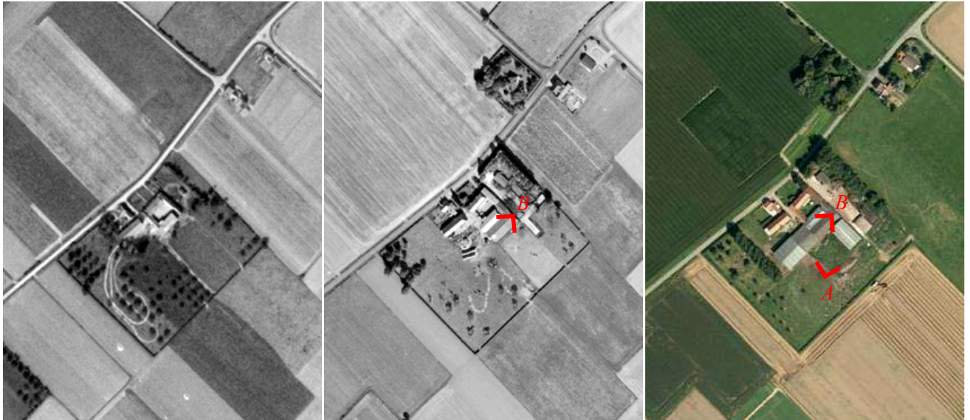
Fig. 35 Des photos aériennes montrant le corps de ferme au moment de sa reprise par Thérèse Laméarnt et Michel Burette (1960); par Jean-Marc Burette et Élisabeth Paquet (1991) et en 2012.
