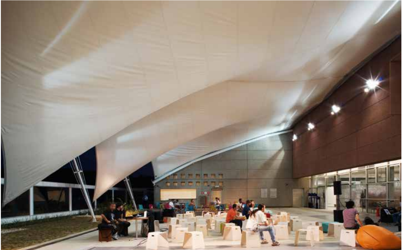
La copertura con tensostruttura
