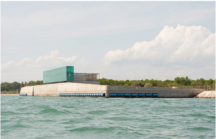
Fig. 3 : Bocca de Malamocco, projet de Alberto Cecchetto pour la culée nord. Photo par Giacomo Strelotto, 2020.
