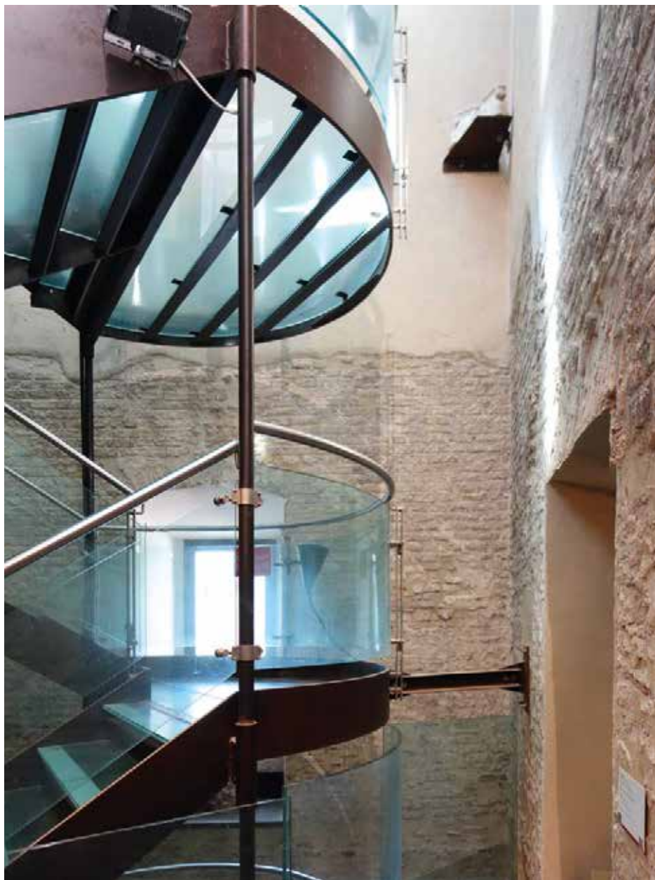
100. Palazzo Chigi , Formello, la scala in acciaio e vetro dentro la torre. Si notino gli elementi in acciaio di collegamento con le murature perimetrali. Ph. Giorgio Danesi, 2023.
