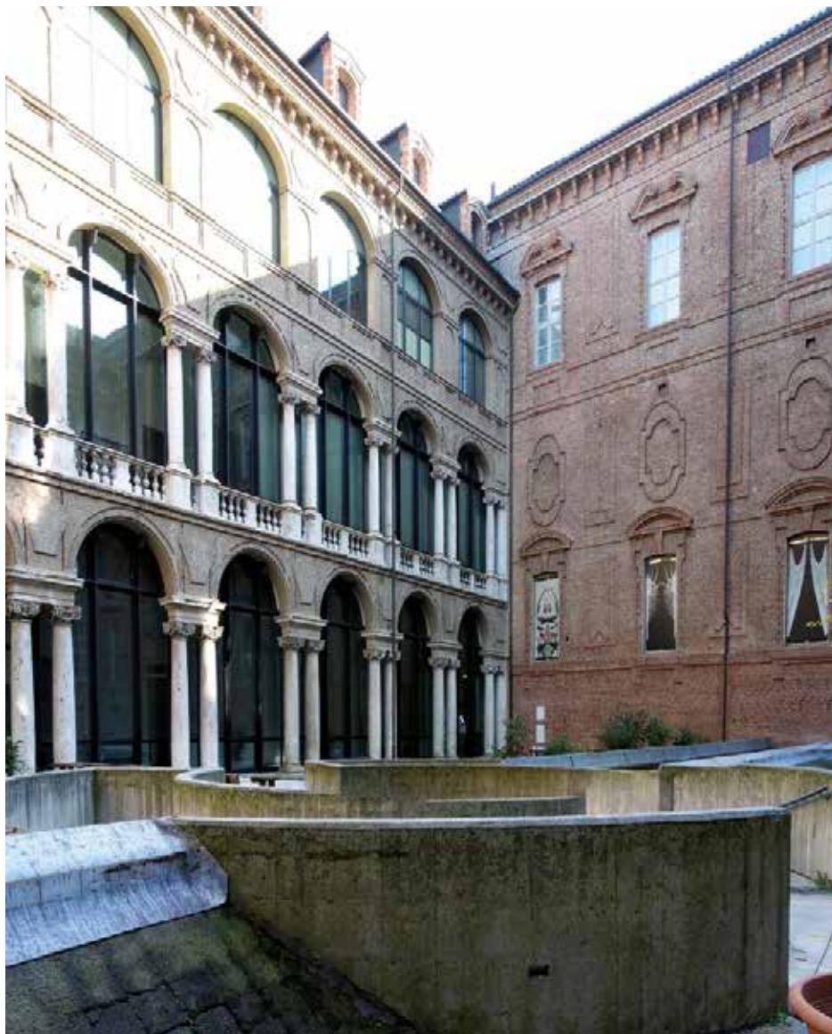
67. Ex Ospedale di San Giovanni , Torino, cortile nord. Si notino sul fondo l'infisso-centine, nella porzione bassa dell'immagine, una delle scale circolari in calcestruzzo armato a vista per la discesa nelle sale ipogee. Ph. Giorgio Danesi, 2023.
