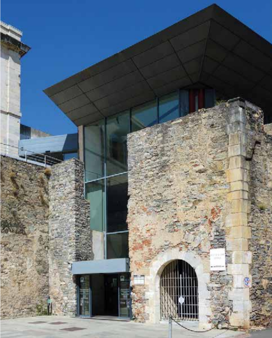
48. Cittadella di Corte , Corsica, ingresso ricavato da un taglio nella muratura del perimetro bastionato. Dietro alla muratura medievale si erge il nuovo volume in acciaio e vetro, la cui lama di copertura si estende a coprire le creste murarie preesistenti. Ph. Giorgio Danesi, 2023.
