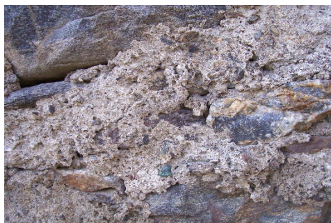
Fig. 13- Castello di Ossana. Composizione della malta di connesura originaria (foto di Isabella Zamboni, 2010).
