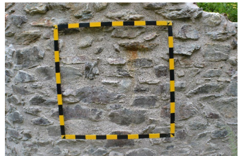
Fig. 12- Caso III. Paramento dopo il restauro (foto di Isabella Zamboni, 2011)
