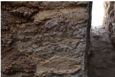
Fig. 7- Caso II. Sovrapposizione tra malta originaria (dx) e di restauro (sx) (foto di Isabella Zamboni, 2010).
