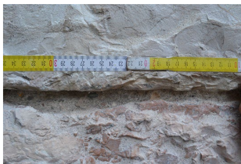
Fig. 15- Torre Civica, paramento restaurato. Sono visibili le integrazioni lapidee e quelle relative ai giunti di connesura (foto di Isabella Zamboni, 2011).
