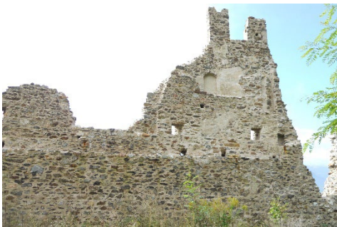
Fig. 10- Caso III. Paramento interno dopo il restauro (foto di G.G., 2011).
