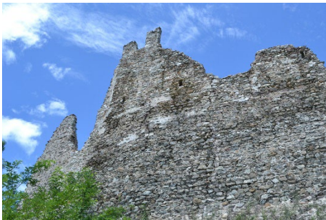
Fig. 9- Caso III. Paramento esterno con tracce di sopraelevazione della cinta merlata (foto di G.G., 2010).
