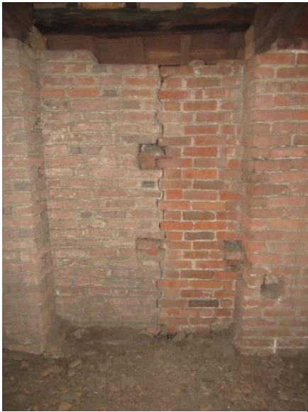
49. Carmine di Pavia, sottotetto della navata maggiore, particolare della muratura a pettine tra la terza e quarta campata.
