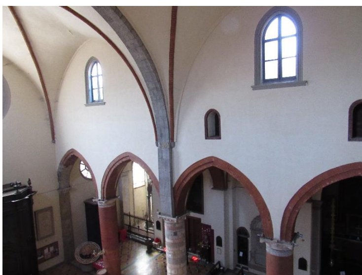
83. Carmine di Milano, vista interna della prima campata maggiore. Si noti l'apparente assenza in essa delle monoforine di illuminazione dei sottotetti, tuttavia esistenti e visibili dall'esterno, ma poste a una quota superiore rispetto alle altre.
