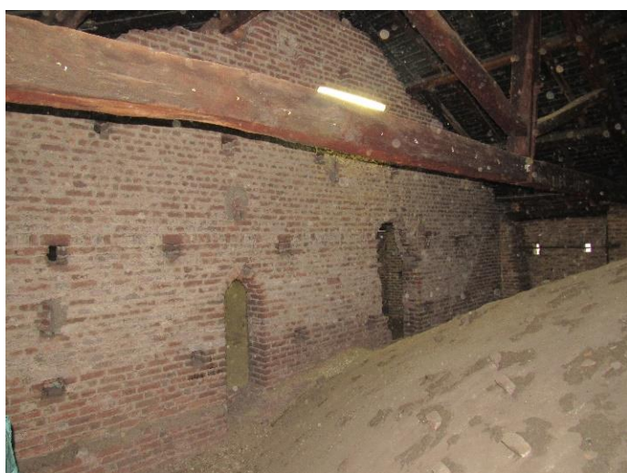
80. Carmine di Milano, sottotetto della navata maggiore; muro-diaframma tra la seconda e la terza campata longitudinale.
