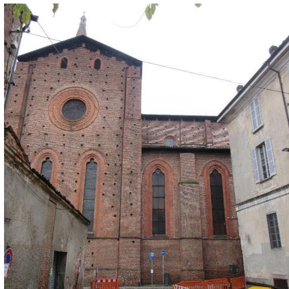
35. Carmine di Pavia, testata del transetto nord. Si noti come esso emerge solo in quota e non in pianta.
