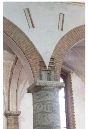
73. San Pietro Martire di Monza, particolare di un pilastro forte, con predisposizione della parasta e dei costoloni della volta mai
