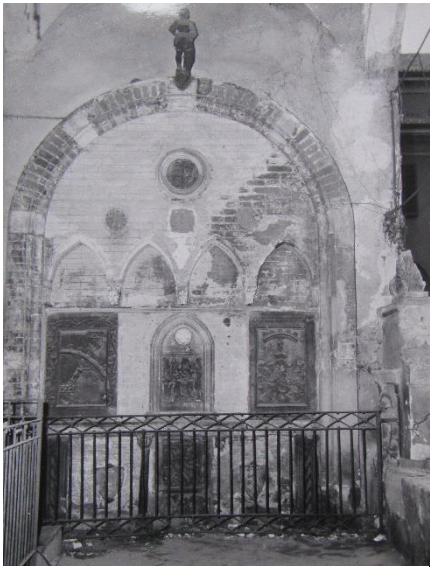
63. Precedente sistemazione del lapidarium del Carmine di Milano (APSMCMi).
