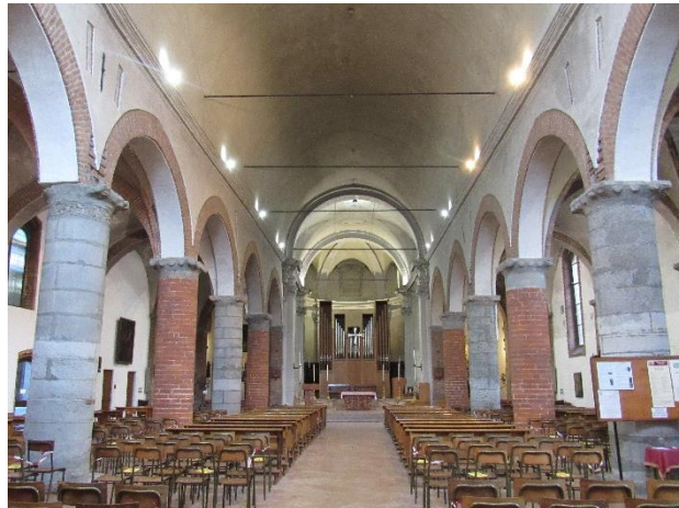
72. San Pietro Martire di Monza, interno. Si noti l'alternanza dei materiali nei sostegni.
