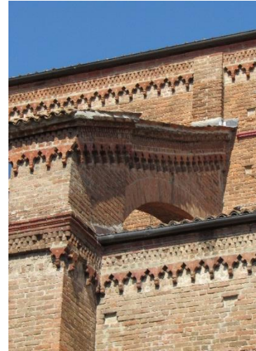
39,40. Sulla sinistra, perimetrale sud del Carmine di Piacenza. Si noti l'emergenza dei contrafforti delle volte maggiori e le arcate originariamente corrispondenti a quelle del chiostro. A destra, particolare dell'arco rampante posto a contrafforte delle volte
