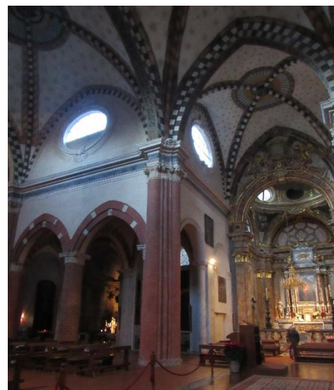
46. San Francesco di Pavia, transetto nord e ultima campata di navata. Si noti il sistema alternato dei sostegni.
