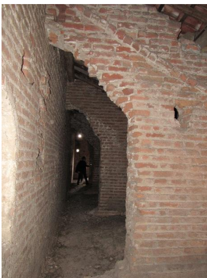
76. Collegiata di Castiglione Olona, sottotetto collaterale nord. Veduta d'insieme dei muri di spina utili alla contraffortatura delle volte maggiori.
