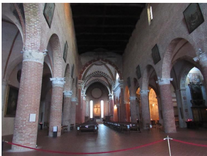
45. San Francesco di Pavia, interno. Si noti il doppio sistema di copertura.
