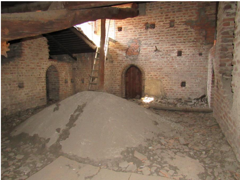
84. Carmine di Milano, vista del sottotetto del collaterale sud. Si noti la presenza di un muro di spina dopo ogni campata della navata minore.
