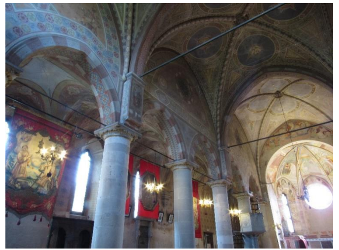
75. Collegiata di Castiglione Olona, particolare del sistema alternato di copertura.
