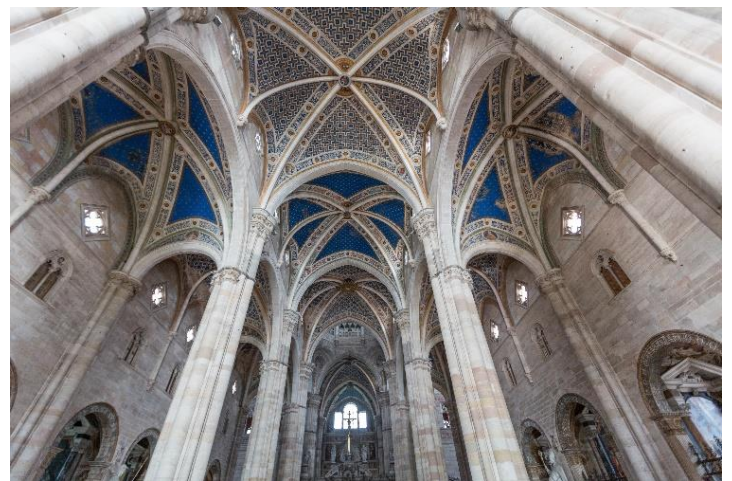
12. Certosa di Pavia, interno della chiesa monastica. Si notino le volte esapartite nella navata centrale e quelle pentapartite dei collaterali.
