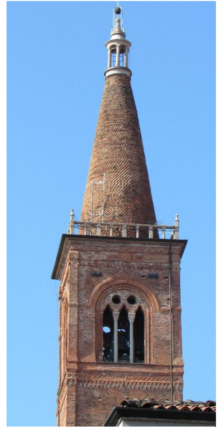
24. Trifora del campanile del Carmine di Pavia.
