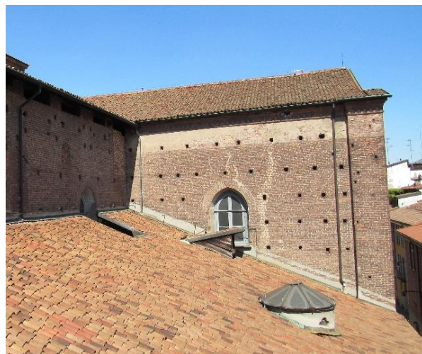
79. Carmine di Milano, visuale esterna del transetto sud dal tetto della navatella. Si noti come la struttura si appoggi ai perimetrali dell'invaso longitudinale.
