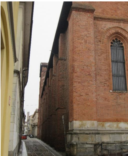
34. Carmine di Pavia, perimetrale nord. Si notino i contrafforti interrotti alla quota delle falde.
