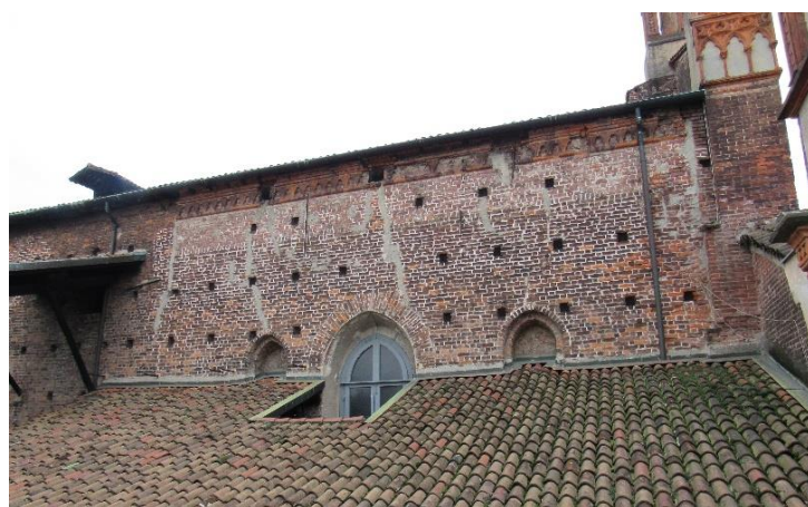
81. Carmine di Milano, esterno della prima campata della navata maggiore, lato nord. Si notino le due aperture tamponate, originariamente pensate come comunicanti coi sottotetti delle navate minori.
