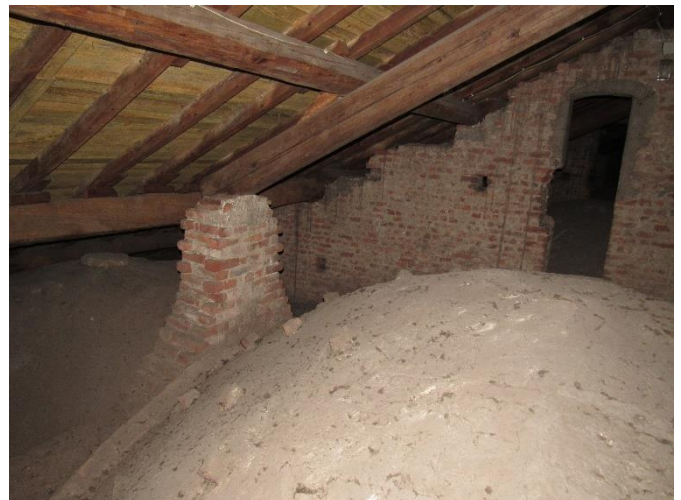
94. San Pietro in Gessate, sottotetto del collaterale nord, particolare dei muri di spina.
