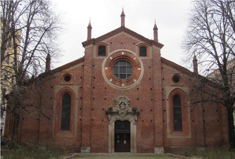
89. San Pietro in Gessate di Milano, facciata.
