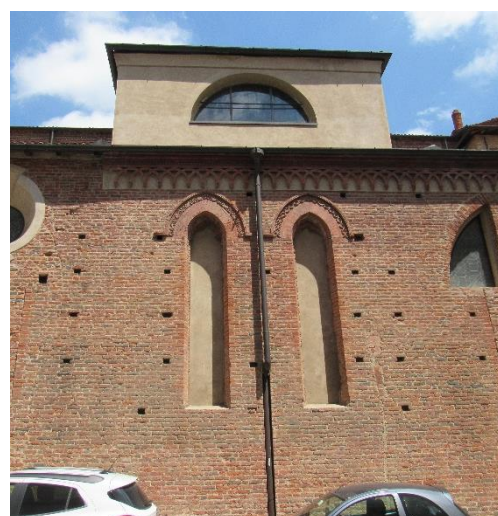
48. San Francesco di Pavia, particolare di una cappella laterale, in cui si sono conservate le due finestre a lancetta che originariamente illuminavano tutti i sacelli.
