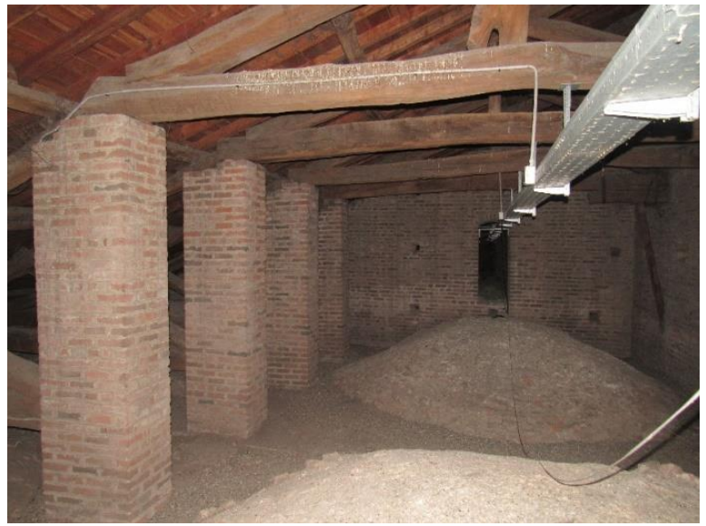
50. Carmine di Pavia, sottotetto della terza campata del collaterale nord. Si notino il grande muro di spina e gli estradossi delle due volte della campatella.
