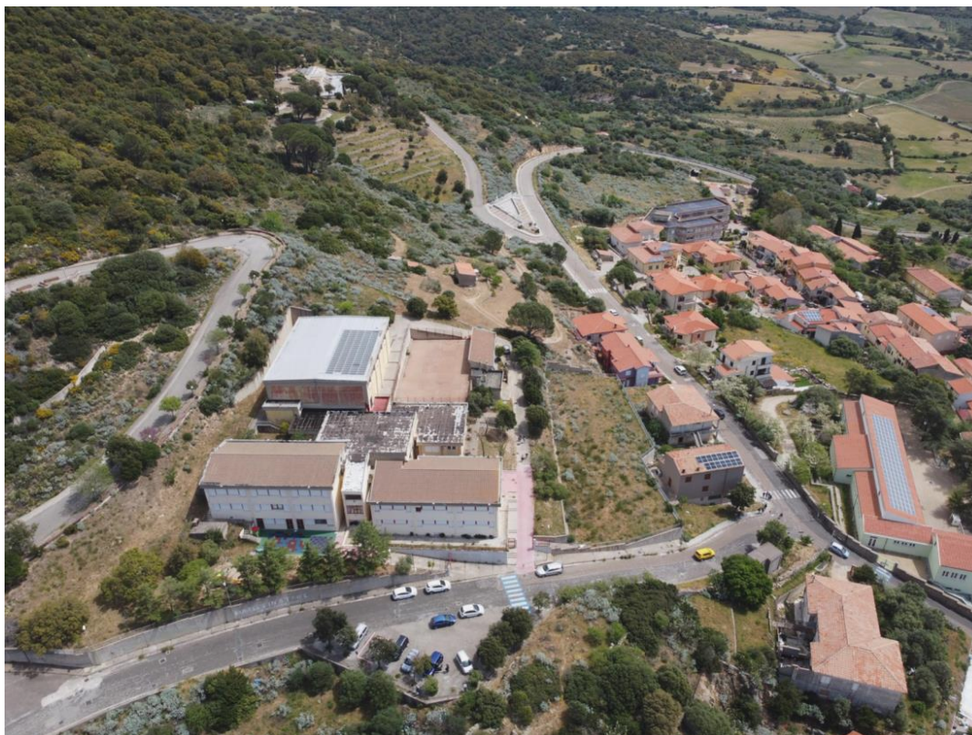
Figura 2 | Berchidda, installazione di pannelli fotovoltaici: in primo piano Scuola Superiore di Primo Grado S.M. P. Casu, sulla destra Scuola dell'Infanzia Via G. Deledda (entrambe parte dell'I.C. G. Elia Lutz - Oschiri). In fondo, sulla sinistra Museo del vino, sulla destra Casa di Riposo per Anziani Maria Bambina (2023).
