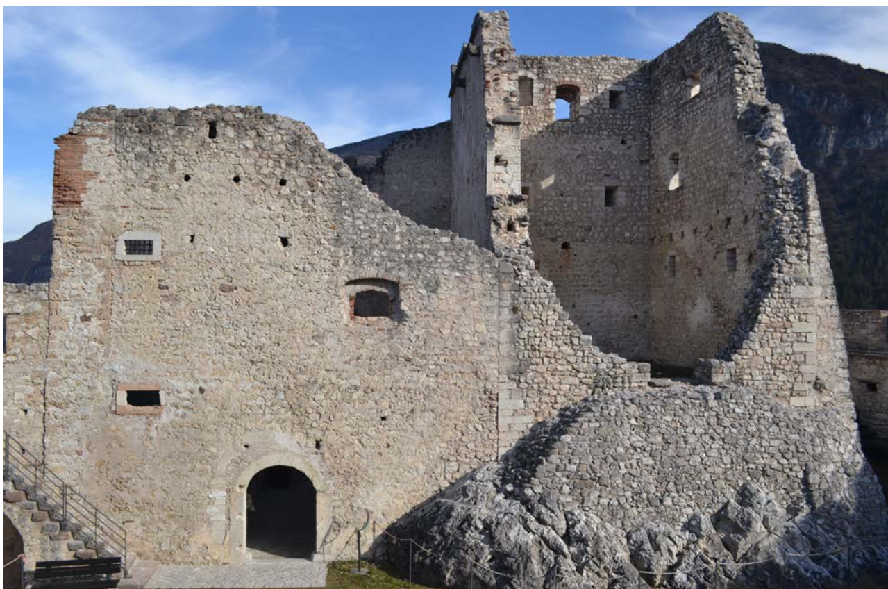
Figura 11: Castel Beseno, Besenello (TN). Complesso della casa-torre meridionale con muro est-ovest. Nella sezione del muro ovest della casa-torre, a livello del primo solaio è visibile traccia di una trave a sezione rettangolare.
