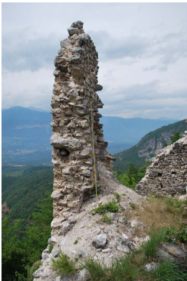
Figura 17: Castel San Pietro, Vigo di Ton (TN). Sezione della prima cinta che presenta conservate in situ travi a sezione circolare ad intervallo di 1,5 m.
