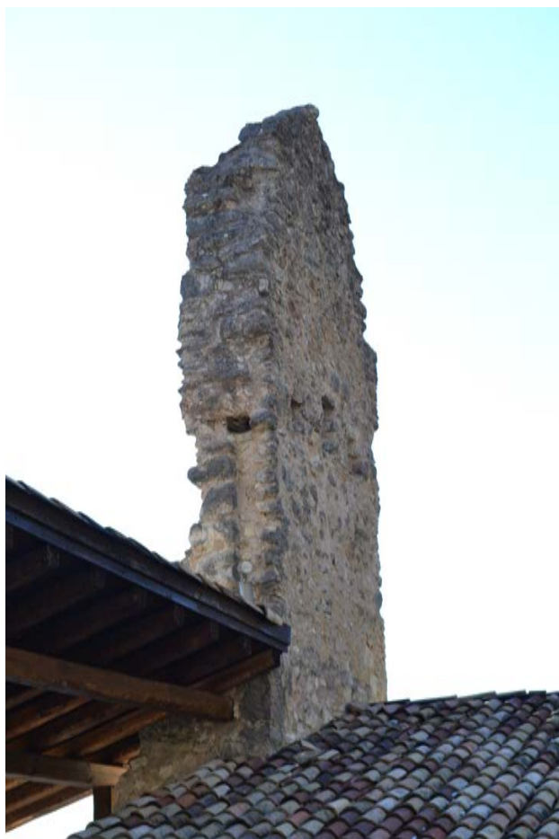
Figura 12: Castel Corno, Isera (TN). Vela muraria della cinta esterna con trave a sezione rettangolare ancora in situ.
