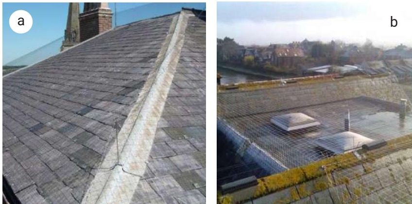
Figura 10. Esempi di installazione di reti antintrusione su edifici. Fonti delle immagini a) https://www.ecold.net/seagull-deterrents ; b) Pacific Grove, CA ( cityofpacificgrove.org ) (data di accesso 29/08/2022).
