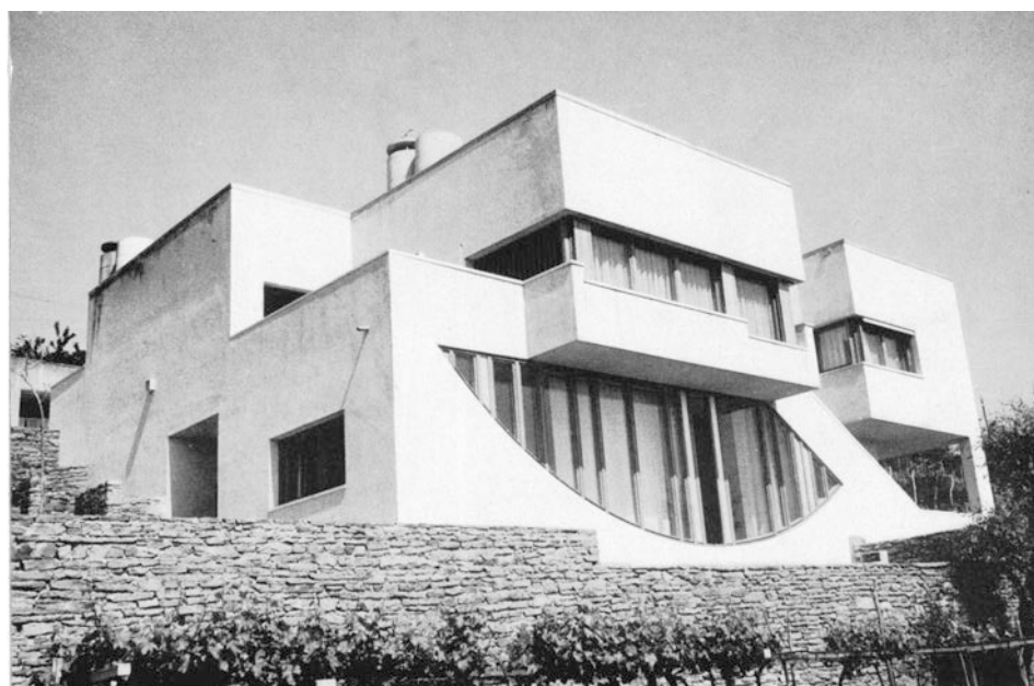
16 | Vista del fronte sud-ovest con la grande finestra ad arco capovolto.
