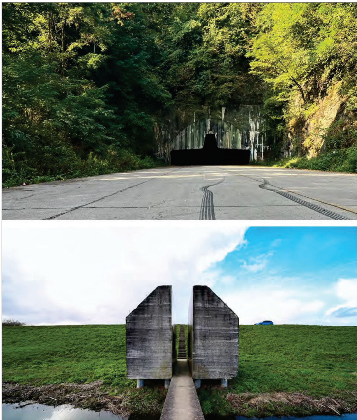
Fig. 3a) – Željava Airbase Bunker, Željava, Croazia e Bosnia ed Erzegovina (Fonte: fotografia di C. Mariotti, 2024); 3b) Bunker 599, Culemborg-Diefdijk, Paesi Bassi (Fonte: fotografia di Lluunnoo 2020, Licenza Creative Commons).
