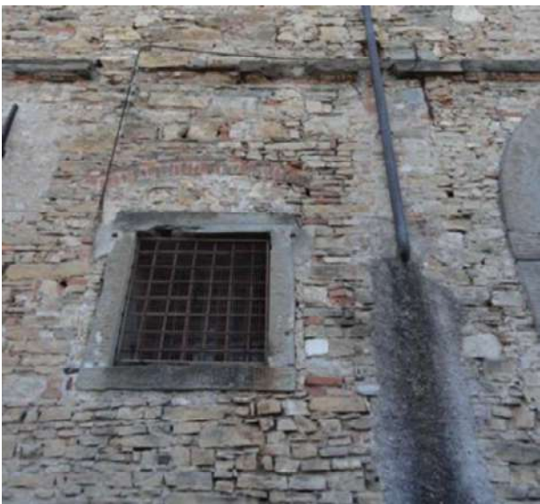
6: Il fronte stratificato su via Vagine consente di osservare i resti di un'apertura ad arco bardellonato, in seguito più volte modificata, in seguito alla formazione di grandi aperture rettangolari, a loro volta ridotte per l'adeguamento dell'edificio a carcere. Si osservano anche alcuni tiranti del raffinato sistema di contenimento delle spinte formato da elementi metallici e teste in pietra inserite nella muratura.
