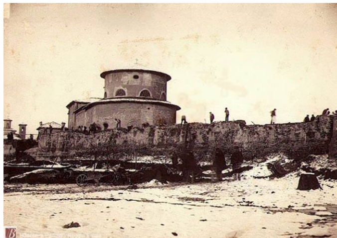
6. La chiesa di San Girolamo durante la demolizione delle mura nel 1885, foto di G. Fantuzzi, Reggio Emilia, Biblioteca Panizzi
