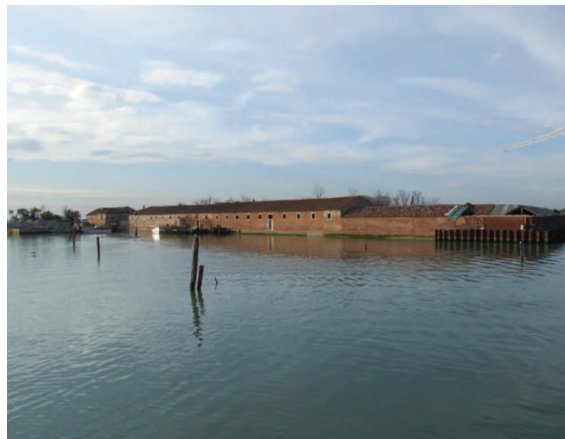
tezon vecchio, prospetto esterno
