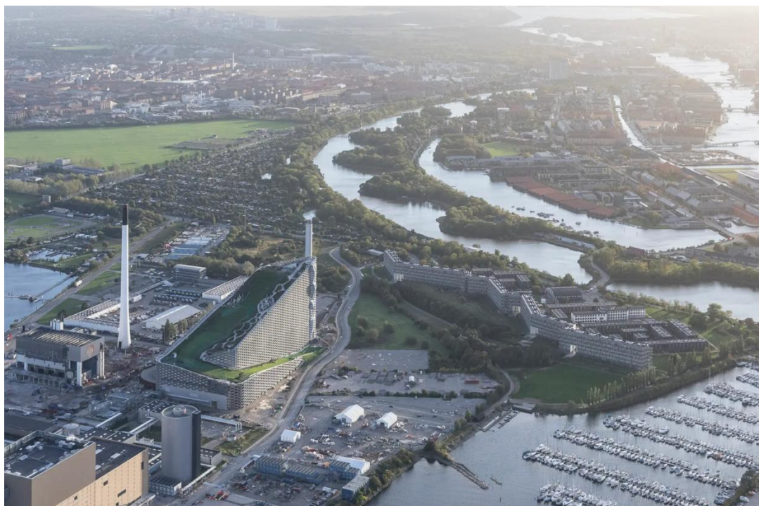
fig.6 – Bjarke Ingels Group, Termovalorizzatore di Copehagen - CopenHill (2019).
