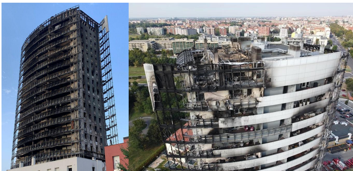
fig.10 – Torre dei Mori, Risultato dell'incendio del 2021.
