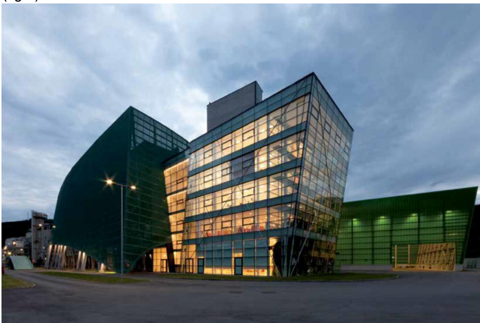
fig.5 – Cleaa Associati, Termovalorizzatore di Bolzano (2013).
