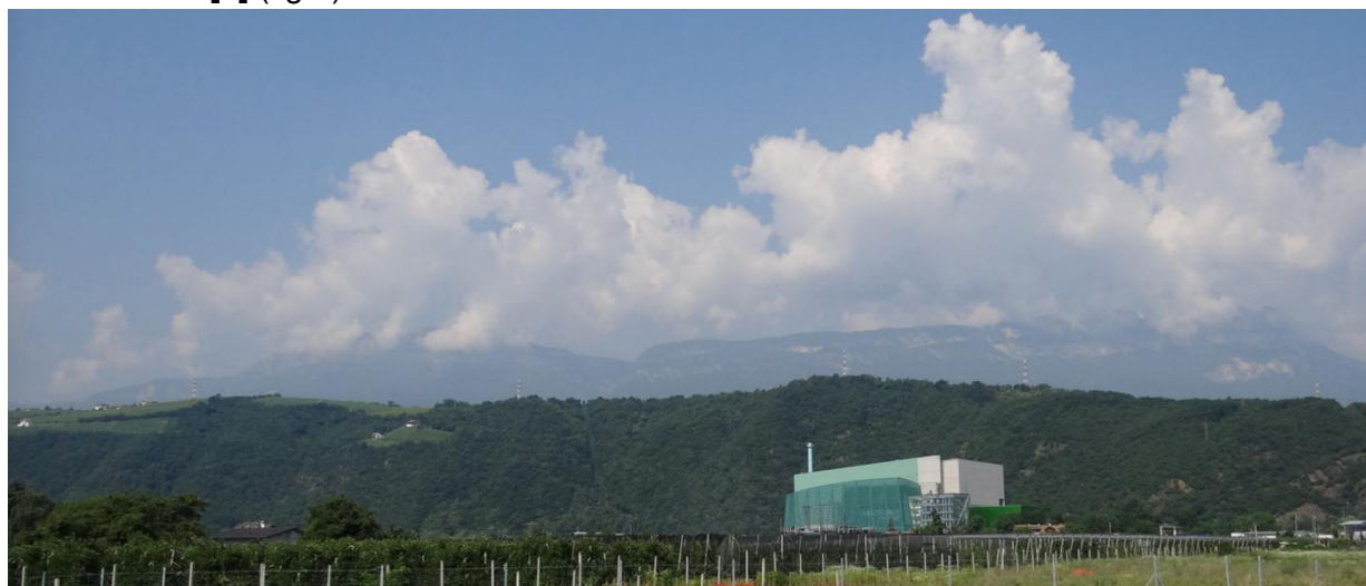
fig.1 – Cleaa Associati, Termovalorizzatore di Bolzano (2013).
