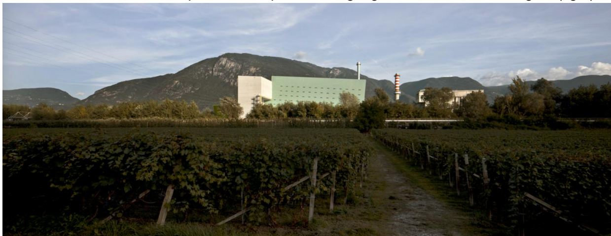
fig.2 – Cleaa Associati, Termovalorizzatore di Bolzano (2013).
