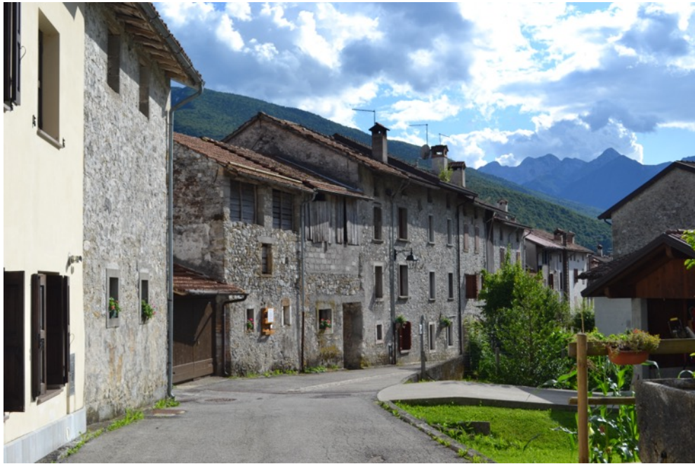
4: Tipo abitativo andreano "a ballatoio su setti", lato nord con visibili interventi di trasformazione. [I. Zamboni, agosto 2023].
