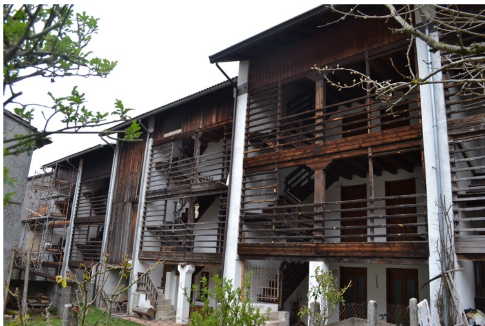
3: Tipo abitativo andreaio “a ballatoio su setti”, lato sud [I. Zamboni, marzo 2023].
