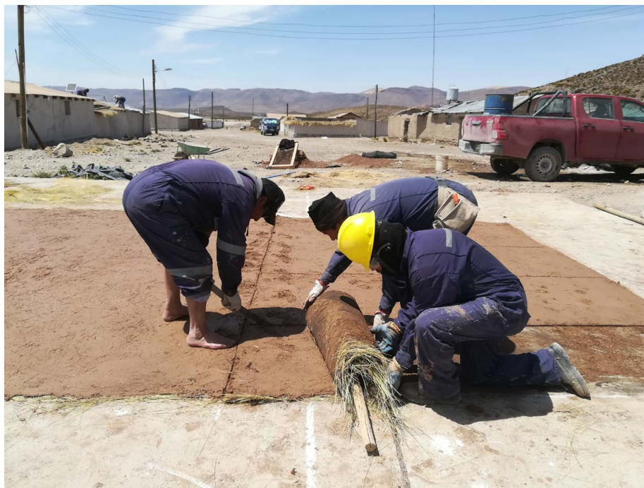
fig. 2. Realizzazione dell'isolamento in terra e paglia per le coperture denominato "caruna" durante un volontariato con Fundación Altiplano nel villaggio di Tacora (Cile)
