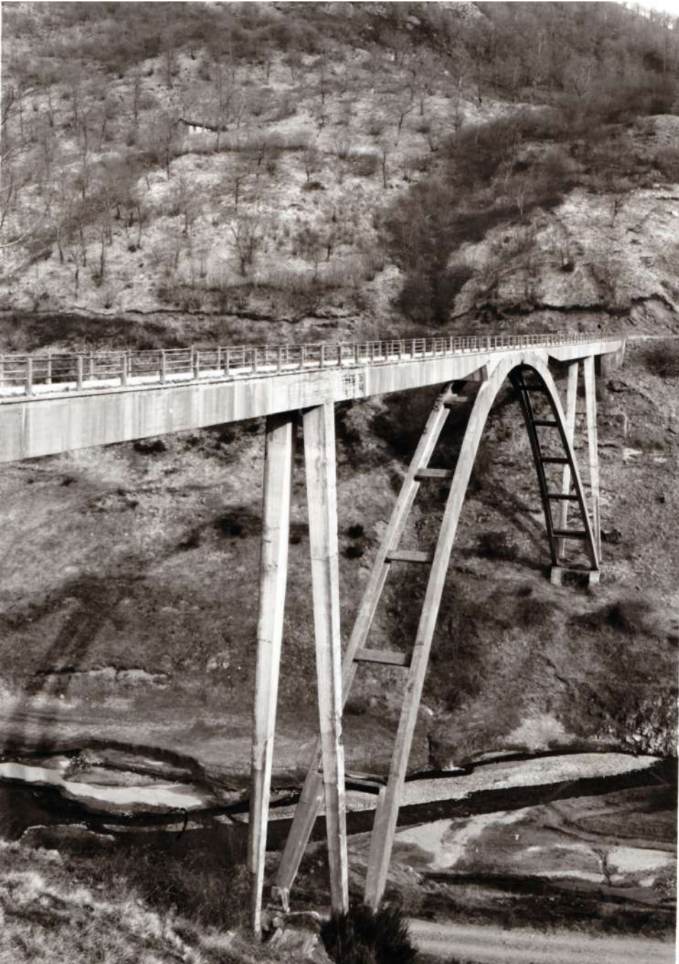
Fig. 2. R. Morandi, passerella pedonale a Vagli di Sotto, Lucca, 1952-1954.
