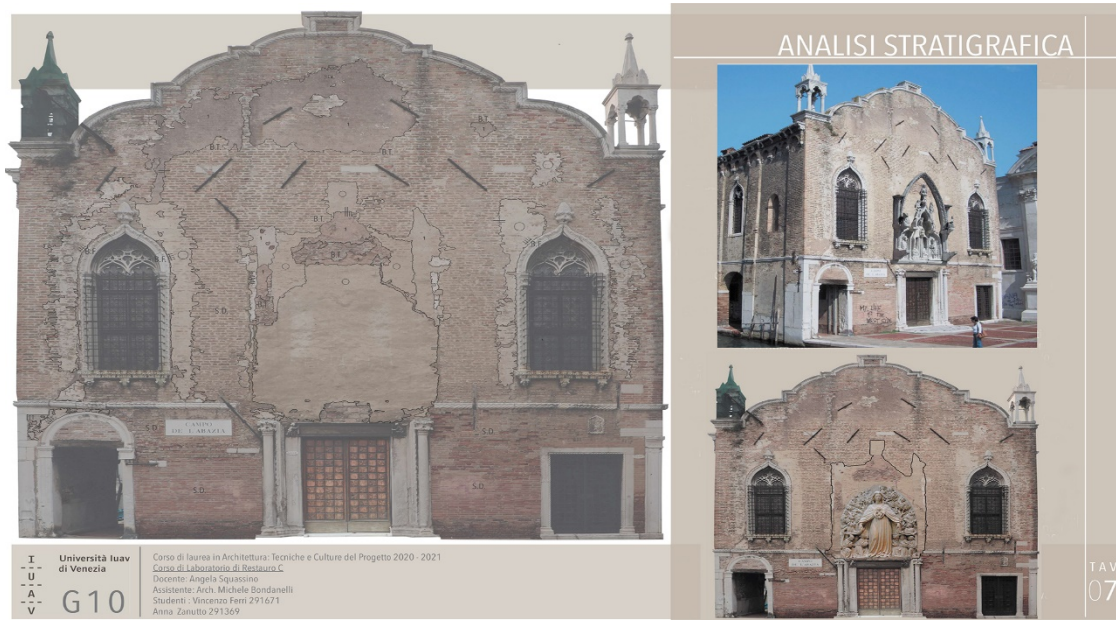
Fig. 4 Scuola Vecchia della Misericordia, Venezia. Lettura stratigrafica della facciata dell'edificio (sec. XIV-XV) e ricollocazione simulata di due portal di cui sono evidenti le tracce. Il primo portale (in alto a destra) è oggi posto all'ingresso del vicino ospizio; il secondo, scolpito da Bartolomeo Bon alla metà del Quattrocento, fu rimosso nel 1612 ed è oggi conservato al Victoria and Albert Museum di Londra (Elaborati degli studenti Vincenzo Ferri e Alessia Zanutto, Università Iuav di Venezia, prof. A. Squassina, a.a.2020-21)
