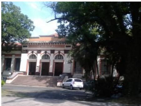
Figura 100: Edificio central sede della amministrazione dell'ESALQ (fonte: Autore)
