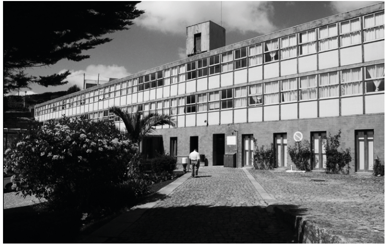
figg. 17, 18 Casa per anziani, Baião. Il ponte che collega i due blocchi e la facciata del volume a nord. Foto: Tornieri S.
