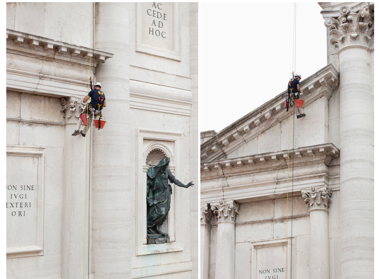
Fig. 9, 10 - A sinistra, intervento dei restauratori climber, aprile 2024; a destra, la facciata durante l'intervento dei restauratori climber, aprile 2024 (foto di Alberto Sinigaglia).
